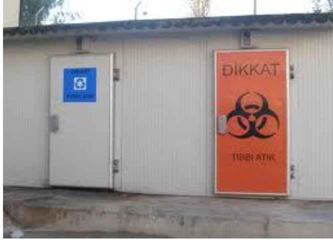
Şekil 2.9. Geçici Atık Deposu
