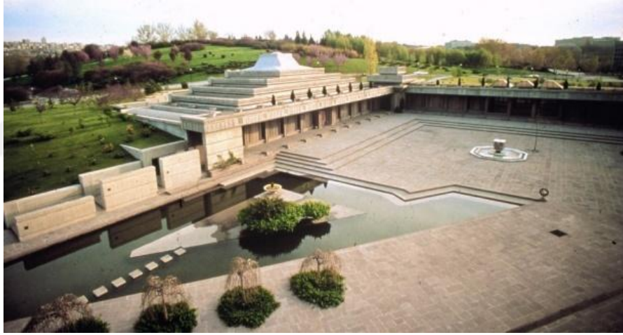
Şekil 4.165 TBMM Camii ön avlusundaki tasarlanmış su-mekanlara bakış (Çinici Mimarlık, bt)
