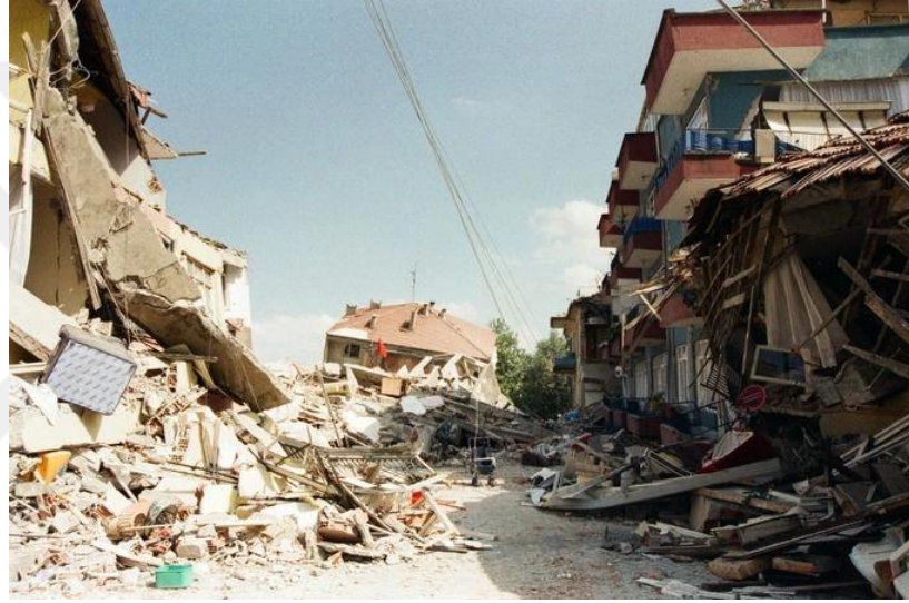
Şekil 60. Kocaeli depremi bina hasarları (ulusal.com.tr, 2024)
