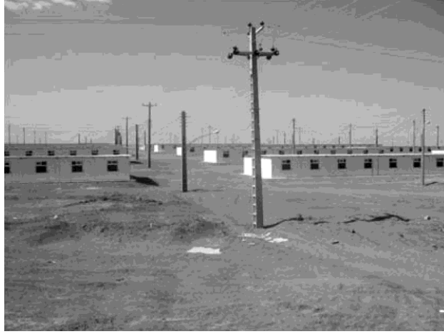
Şekil 91. Şehrin kenarlarında ara barınak inşaatı. (Kharazmi, 2005)
