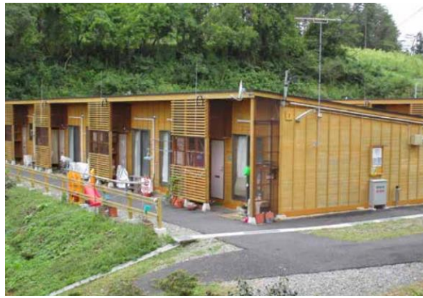
Şekil 41. Miyagi Prefektörlüğü, Kesenuma şehrinde geçici konutlar. Japonya depremi ve tsunamisi, 2011. (Imakawa, 2014)
