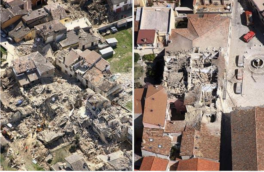
Şekil 100. L'Aquila depremi bina hasarları (Di Lauro, 2016)
