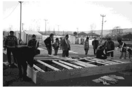
Şekil 6. parçaların sahada birleştirilmesi (all-units.nl, 2024)
