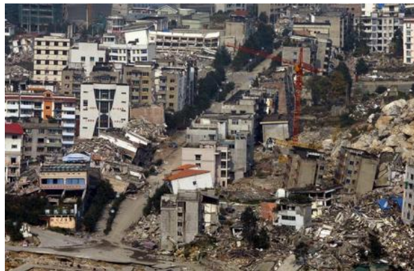
Şekil 81. Sichuan depremi bina hasarları (telegraph.co.uk, 2024)
