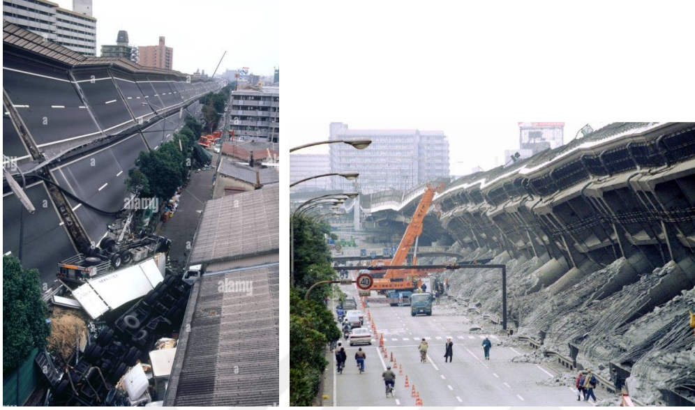
Şekil 35. Kobe Depremi hasarları (alamy.com, 2024)
