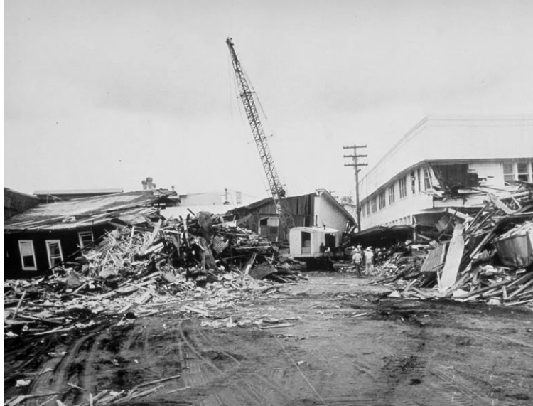
Şekil 49. Valdivia depremi hasarları (onedio.com, 2024)
