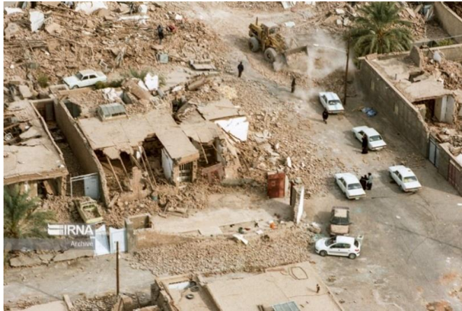
Şekil 88. Bem depremi bina hasarları (irna.ir, 2024)
