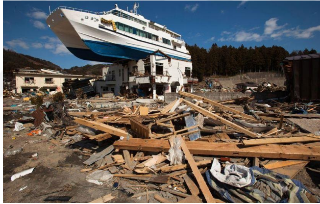
Şekil 39. Tohoku Depremi hasarları (temblor.net, 2024)
