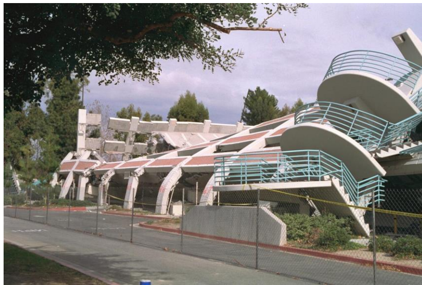
Şekil 108. Northridge depremi bina hasarları (USGS, 1994)
