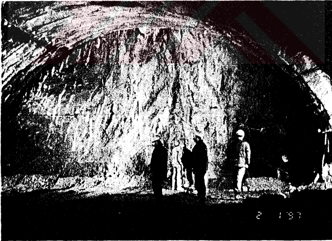
Şekil 3.82. Asarsuyu Girişinde deformasyona neden olan, dokanak boyunca gelişmiş fay killeri ve su.
