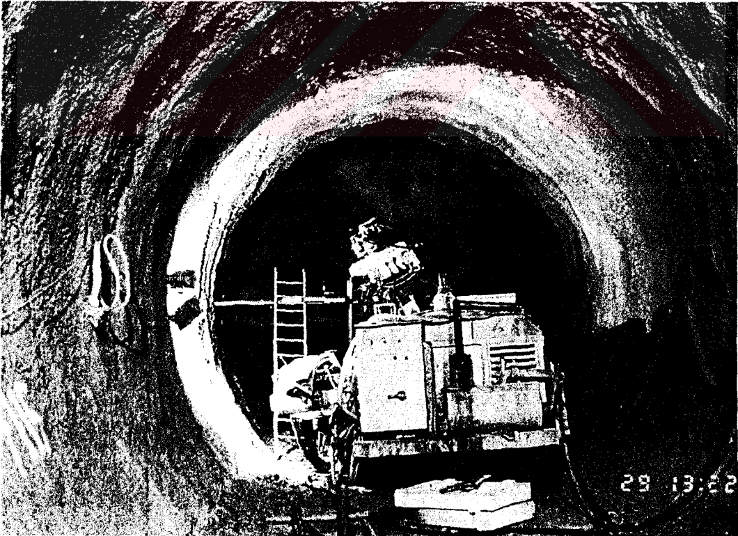
Şekil 2.7. Tünellerde yapılan yatay ve dikine araştırma sondajları.
