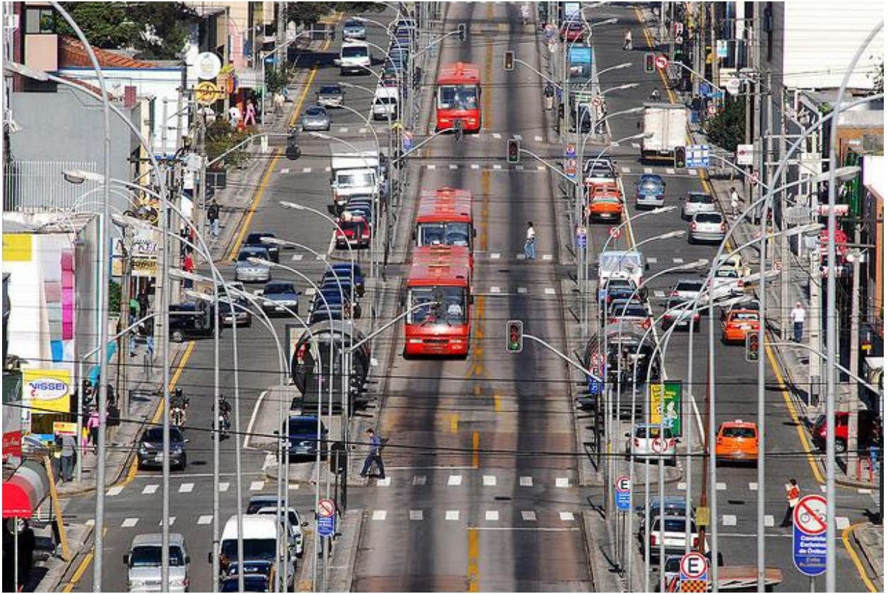
Şekil 6. Curitiba'da BRT otobüslerine özel şerit uygulaması (Görsel Kaynak: Riecke, 2011)
