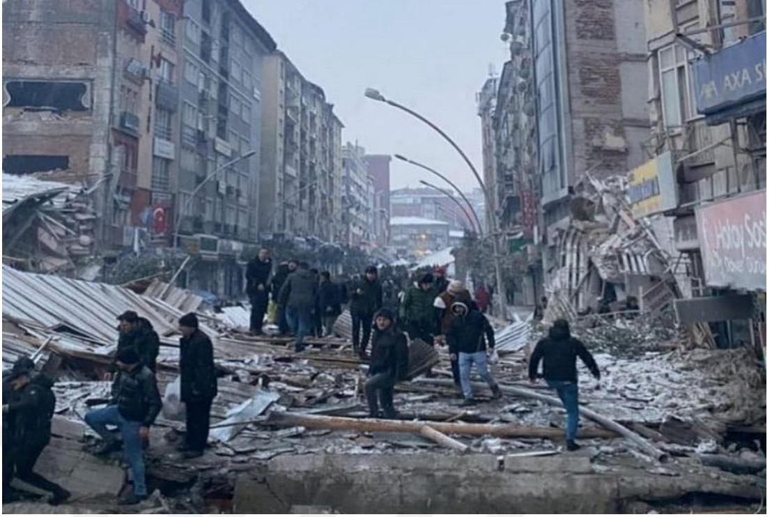
Şekil 1. 3: 6 Şubat 2023 depremleri sonrası Malatya’da enkazlardan dolayı sokağın kapanması.
