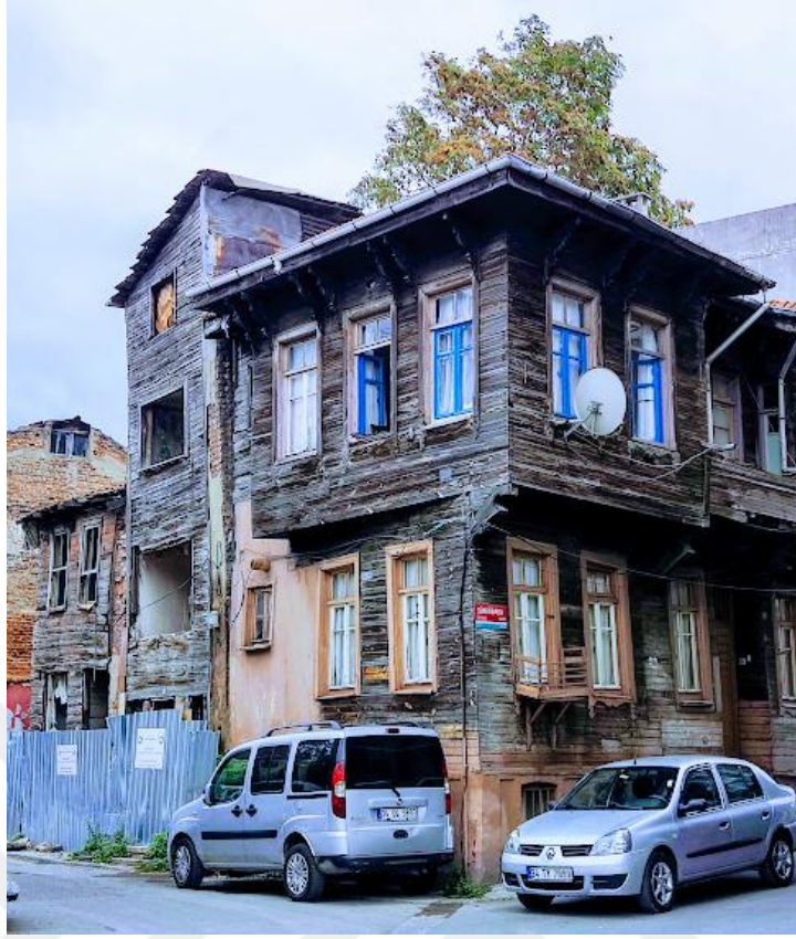
Şekil 3.25: Bakımsız ahşap yapılar (İBB Arşivleri).
