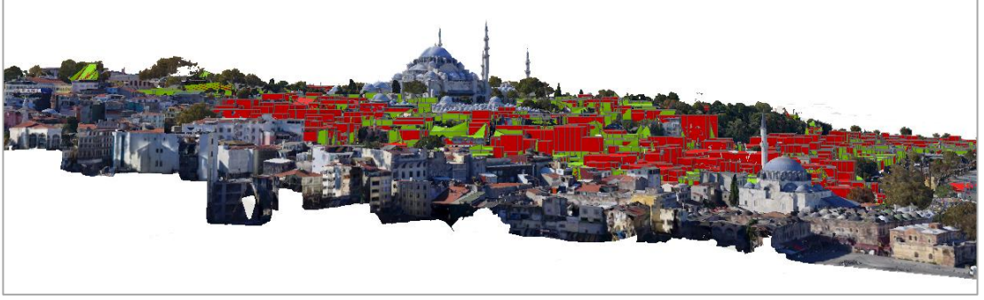
Şekil 4.13 : Zeytinburnu Bölgesinden bakışta çalışma alanı Süleymaniye Bölgesinin siluet görünümü.
