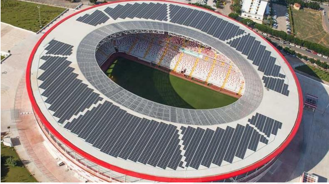
Şekil 1.15. Antalya Şehir Stadyumu Çatı Uygulaması [32].
