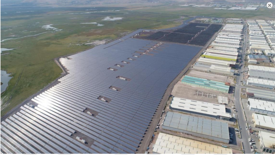
Şekil 1.16. Kayseri OSB Güneş Enerji Santrali [36].
