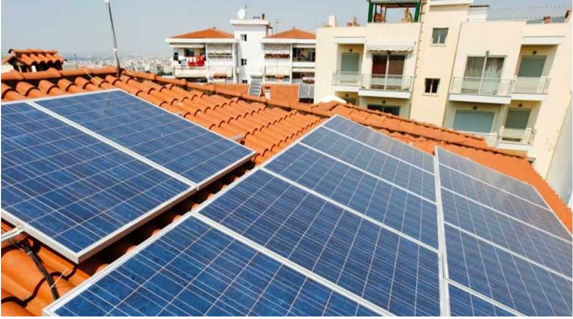
Şekil 1.13. Çatı Üstü Uygulaması [30].
