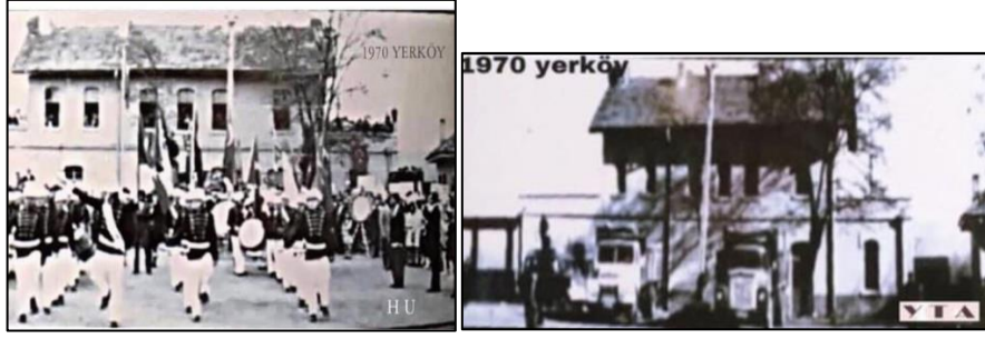
Şekil 5.7-8. 1970’li Yıllarda Yerköy Yolcu Binası (H. Uyar, YTA)
