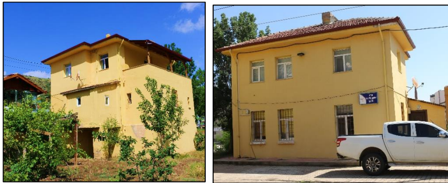
Şekil 4.111-112. Kısım Lojmanı Cephe Görünümü
