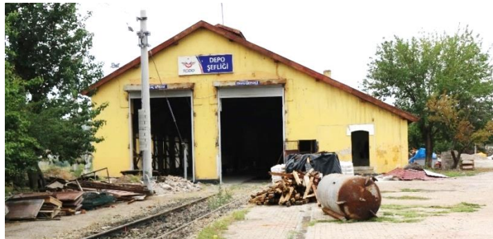
Şekil 4.43. Depo Şefliği Binası, Giriş Cephesi
