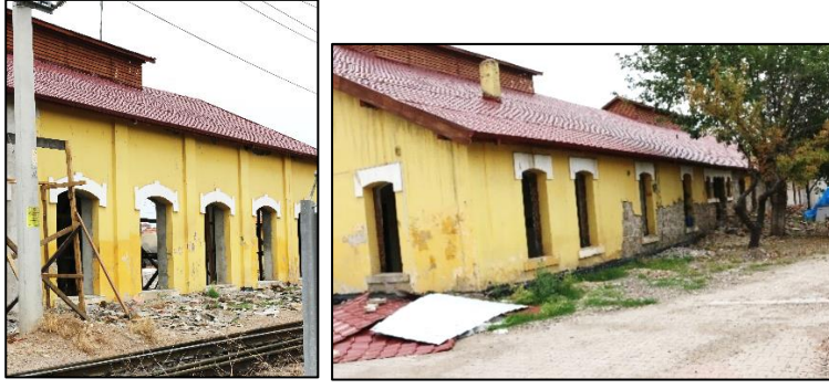
Şekil 4.44-45. Depo Binası Doğu-Batı Cepheler
