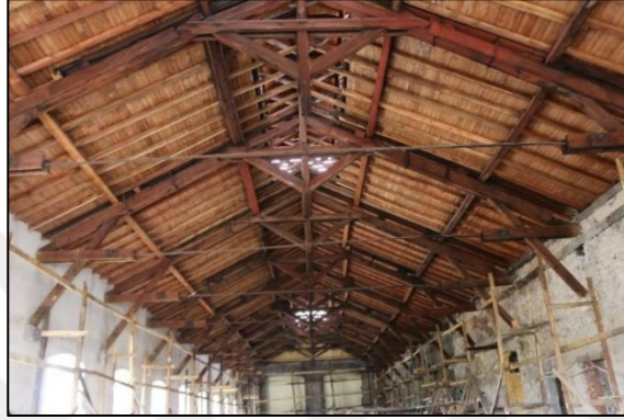
Şekil 4.46. Depo Binası Ahşap Tavan Detayı
