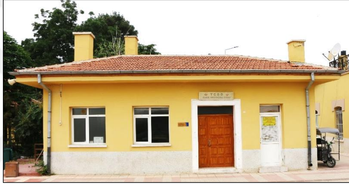
Şekil 4.40. Revizörlük Binası peron Cephesi
