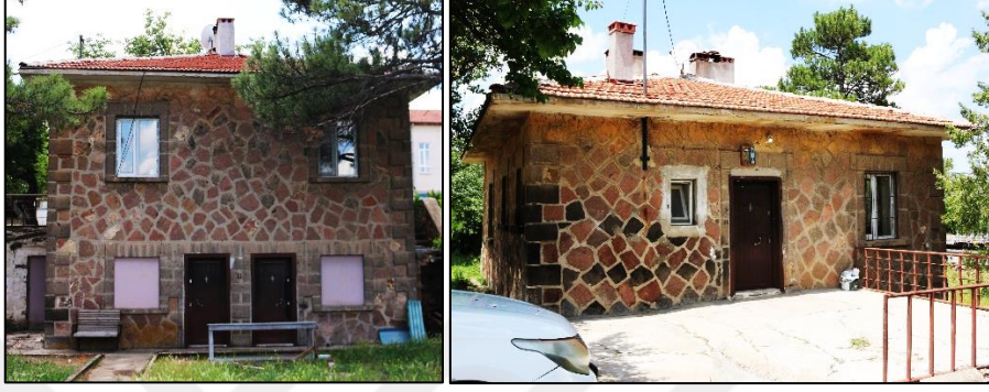
Şekil 4.152-153 Lojmanın Kuzey (sol) ve Doğu Cephelerinin Görünümü
