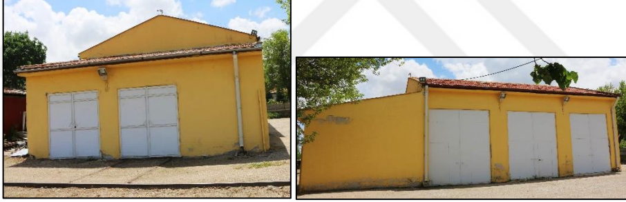
Şekil 4.148-149. Malzeme Garajı Kuzey Cephe (sol) ve Batı Cephe Görünümü
