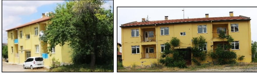
Şekil 4.156-157. Yenifakılı Apartman (sol), Yerköy Apartman (sağ) Giriş Cephe Görünümleri
