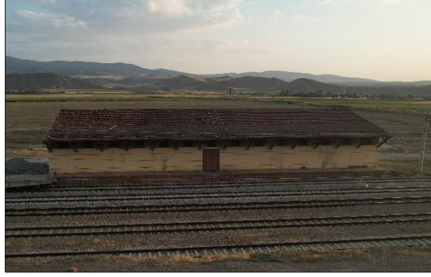
Şekil 4.14. Sekili Açık Hangar Binası
