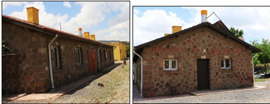
Şekil 4.146-147. Çavuş Lojmanı Kuzey Cephe (sol) ve Batı Cephe Görünümü
