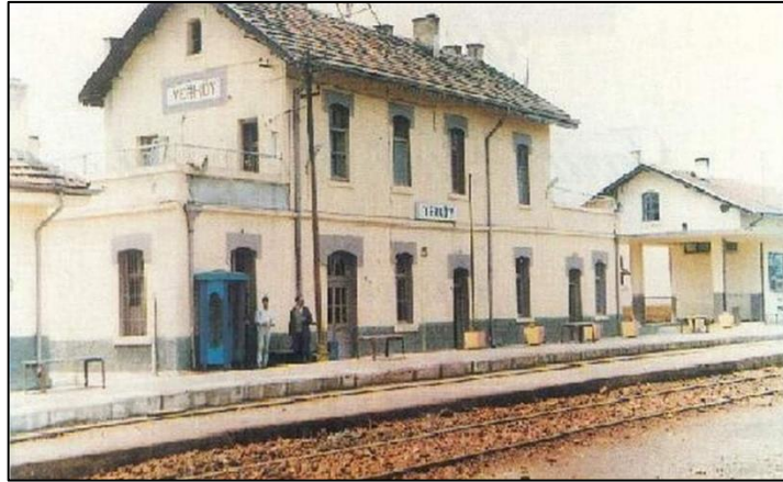
Şekil 4.29. 1990'lı Yıllarda Yerköy Yolcu Binası,
