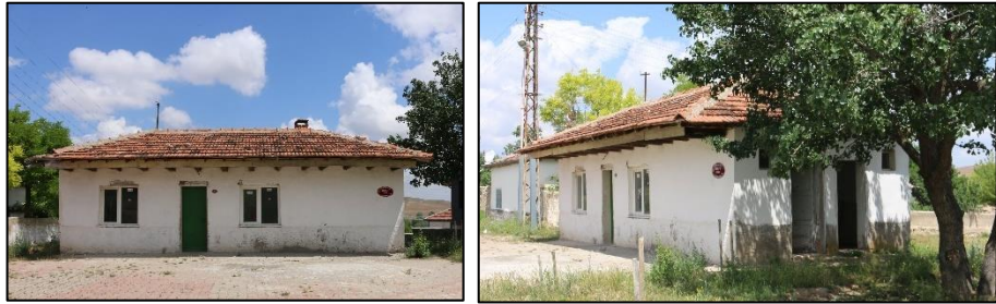
Şekil 4.132-133. Karasenir Yolcu Binası Hat Cephesinden Bir Görünüm.
