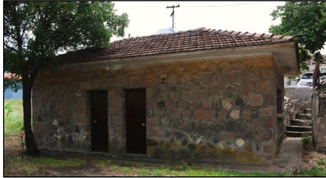
Şekil 4.154. Santral Binası Kuzey Cephe Görünümü
