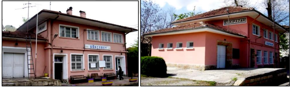
Şekil 5.1.1-2: Gökçebey (sol) ve Eskipazar Yolcu Binaları (TCDD)
