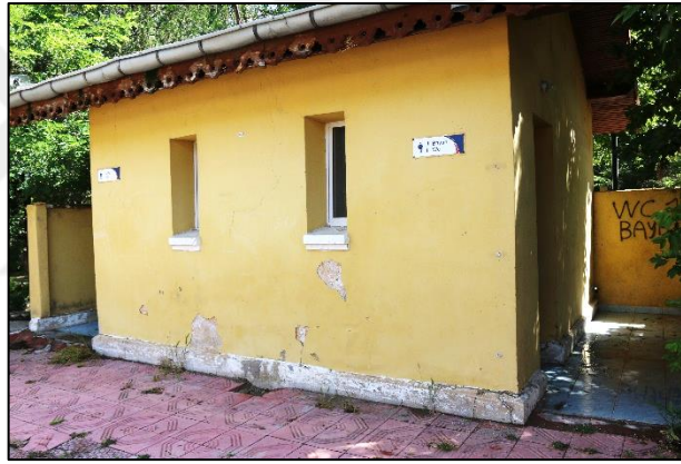
Şekil 4.116. Umumi Tuvalet Yapısına Ait Bir Görüntü
