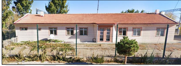
Şekil 4.151. Şeflik Binası Güney Cephe Görünümü
