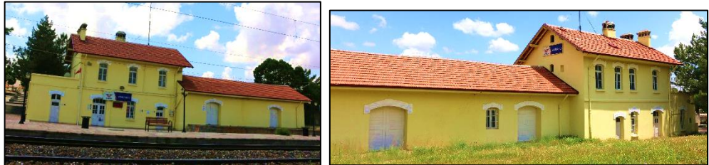
Şekil 4.143-144. Yenifakılı Yolcu Binası Peron Cephesi (Sol) ve Güney Cephe Görünümü
