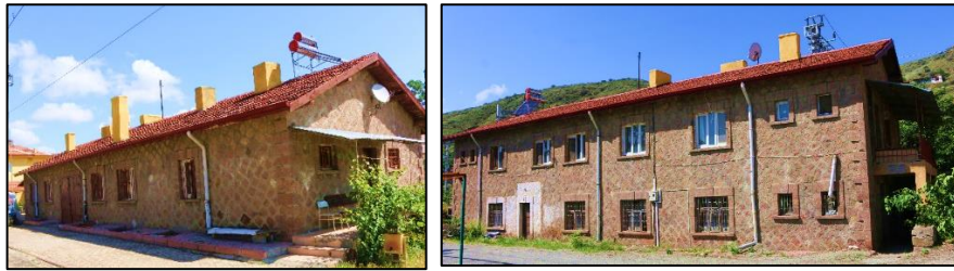
Şekil 4.113-114. Çavuş Lojmanı ve İşçi Barakasının Cephe Görünümü
