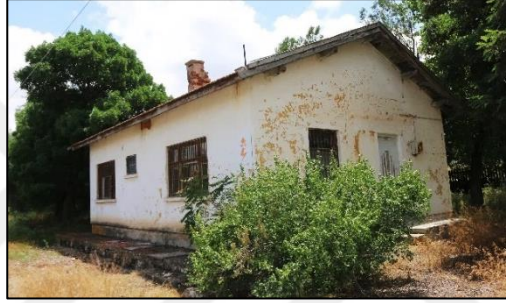
Şekil 4.155 Tek Dairesel Lojman Batı-Kuzey Cephe Görünümü
