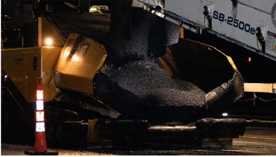
Resim 2.1 Geri dönüştürülmüş plastik içeren asfalt karışımı, Columbia, Missouri'deki U.S. Highway 63 yakınlarındaki Stadium Boulevard'ı kaplamak için kullanılmıştır (İnt.Kyn.4).
