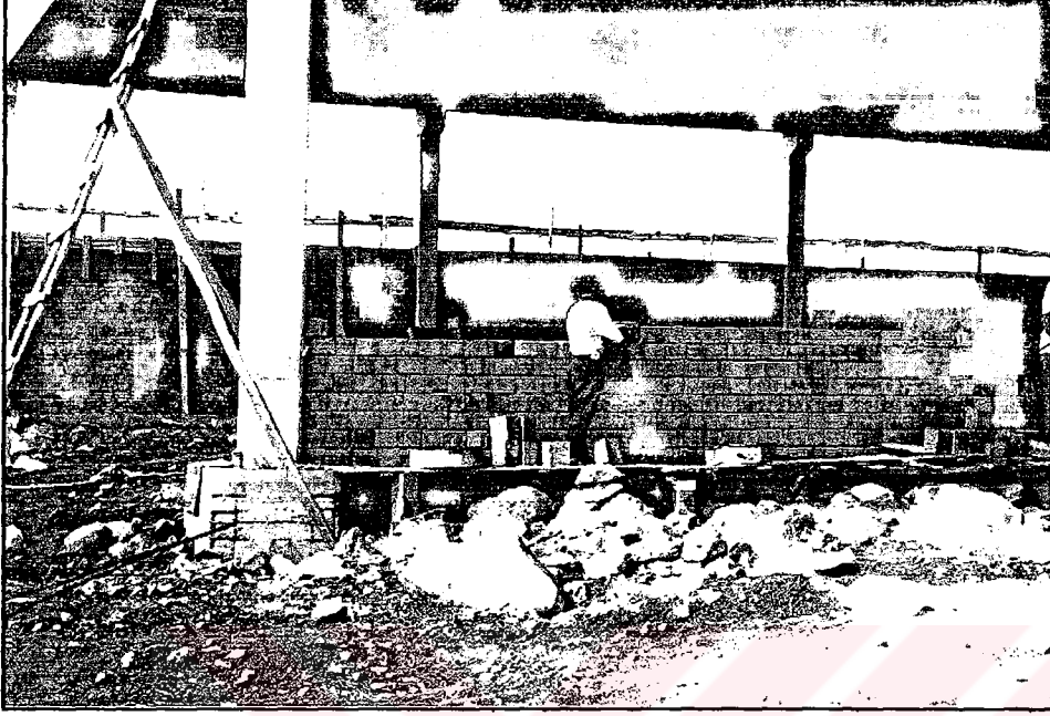
Şekil Ek 15.2. Tuğla duvar örülmesi
