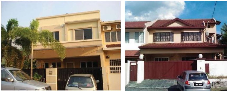
Şekil 2. Malezya Klang Vadisi evlerinde yapılan cephe değişiklikleri
