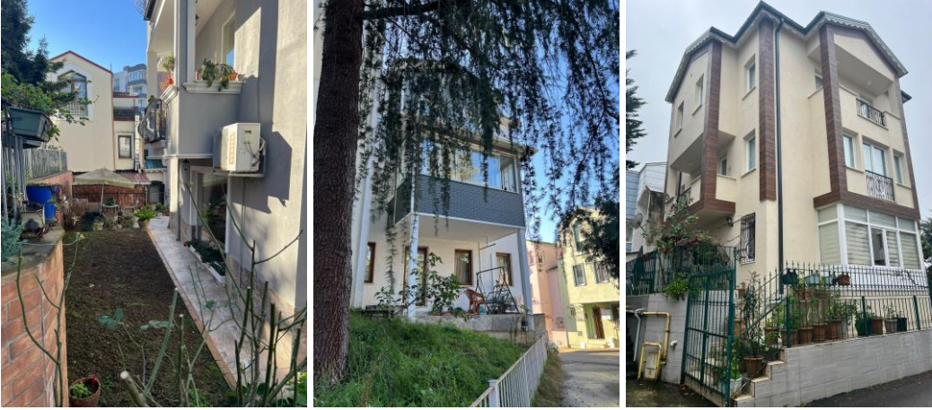
Şekil 16. Cephe değişiklik yapılan pencere kullanımları
