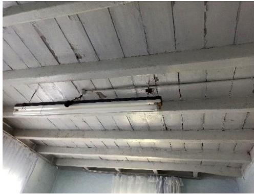
Şekil 2.12: Döşeme örneği (yazarın arşivinden).
