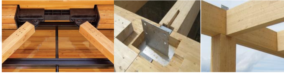
Şekil 3.4: Yüksek ahşap yapılardaki birleşim örnekleri [1].
