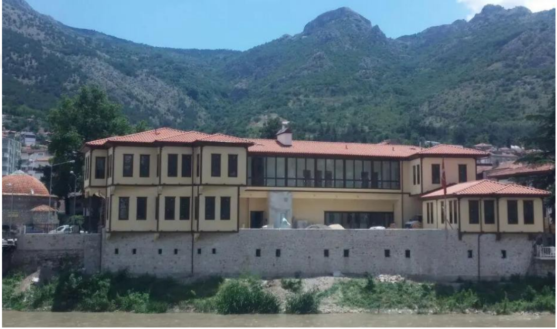
Şekil 3.37 Devamı: Amasya Sarı Konak, (a) yapım aşamasındaki taşıyıcı sistemi, (b) yapım süreci, (c) yapının bitmiş hali [71], [72].
