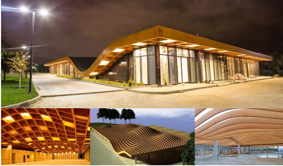
Şekil 3.32: Avcılar Sosyal Tesisleri’nin yapım aşaması ve yapının bitmiş haline ait görseller [65].
