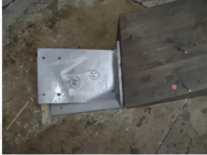
Şekil 3.35: Nevmekân Sahil yapı kubbesine ait bağlantı detayı [68].
