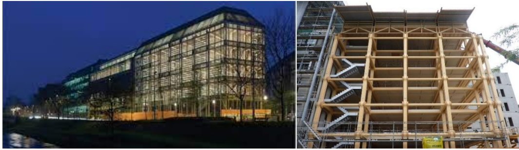
Şekil 3.21: Tamedia yapısına ait strüktür ve cephe görseli [56].
