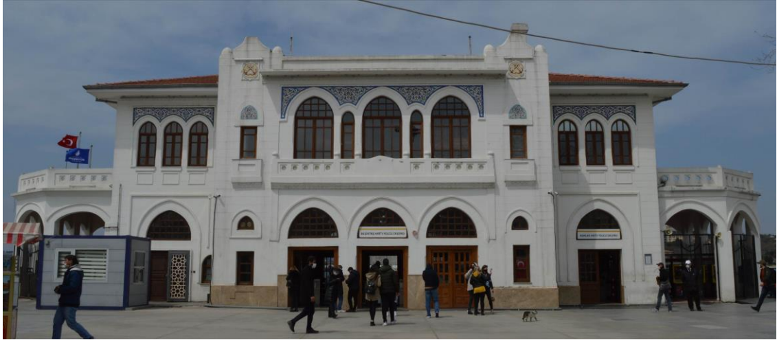
Şekil 4.17. Kadıköy İskelesi kara cephesi görünüşü
