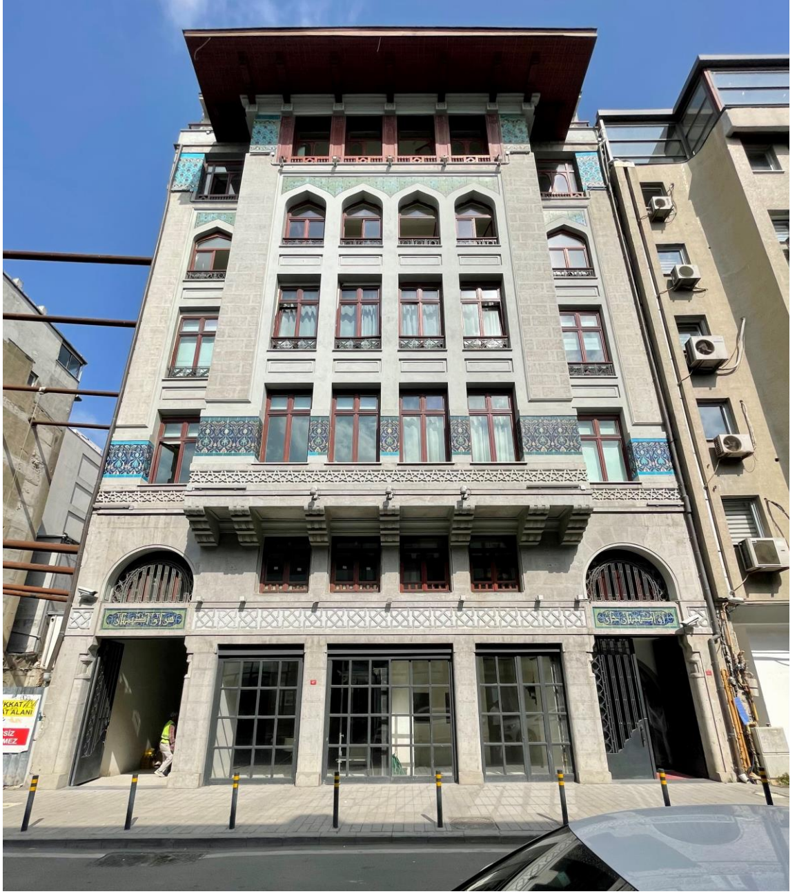
Şekil 4.7. Hovagimyan Han ön cephe görünüşü
