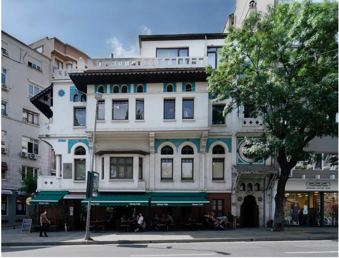
Şekil 4.3. Vedat Tek Evi Vali Konağı Caddesi cephesi
