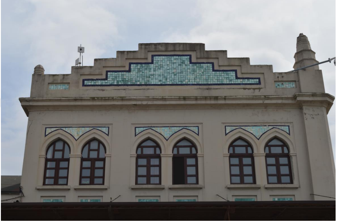
Şekil 4.14. Hal Binası deniz cephesinden kısmi görünüş
