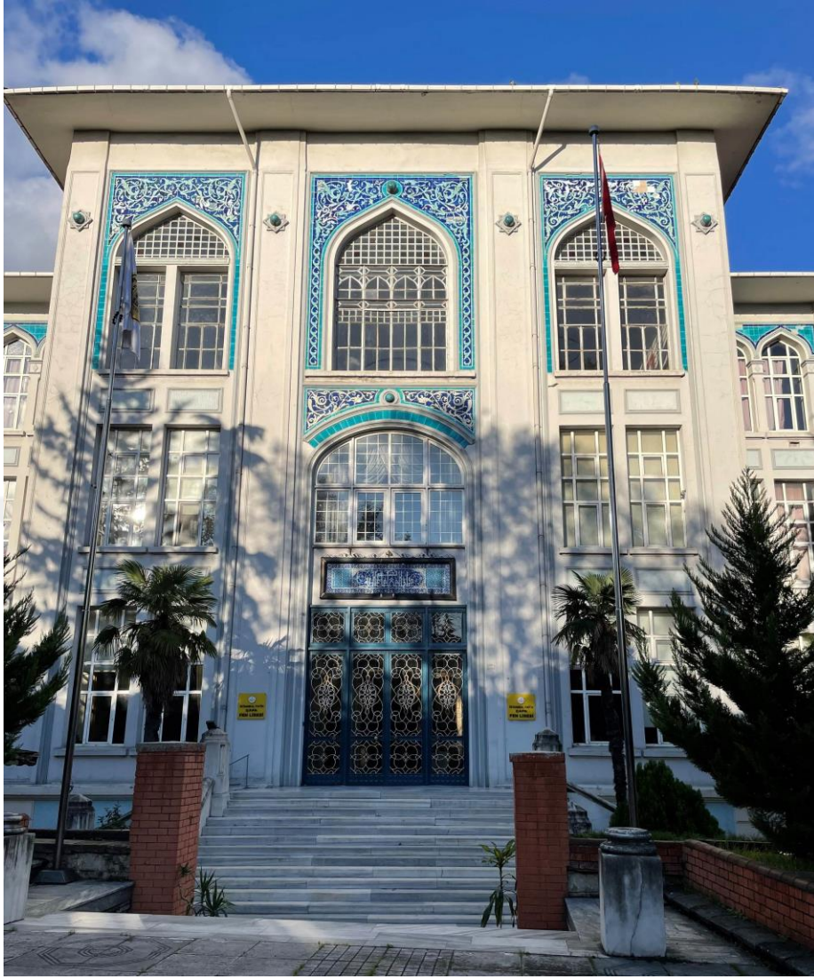
Şekil 4.15. Çapa Fen Lisesi ön cephe giriş kısmının görünüşü
