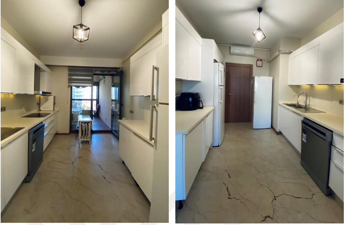
Şekil 4.15: Mutfağın Zemini ve Mutfağın MDF Ahşap Kapısı
