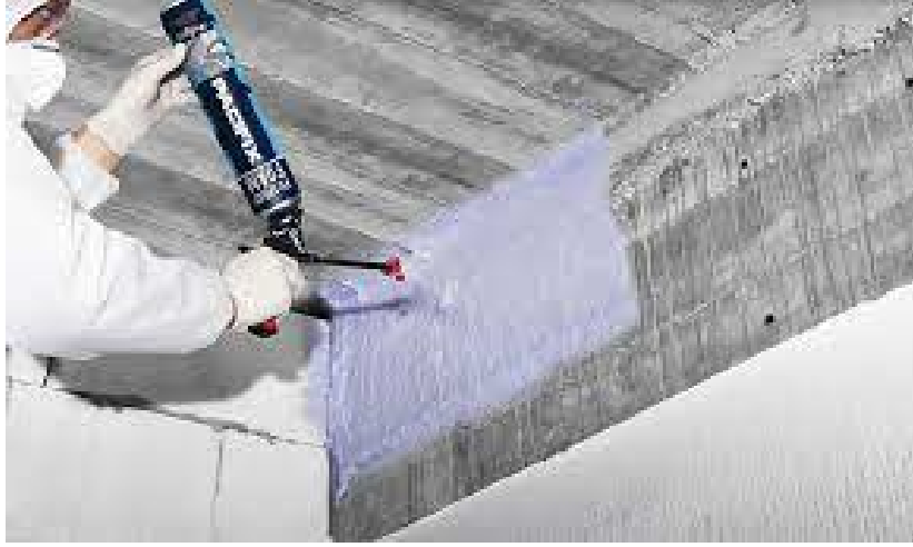
4.1. Duvar ve döşeme birleşim yeri poliüretan köpük uygulaması
