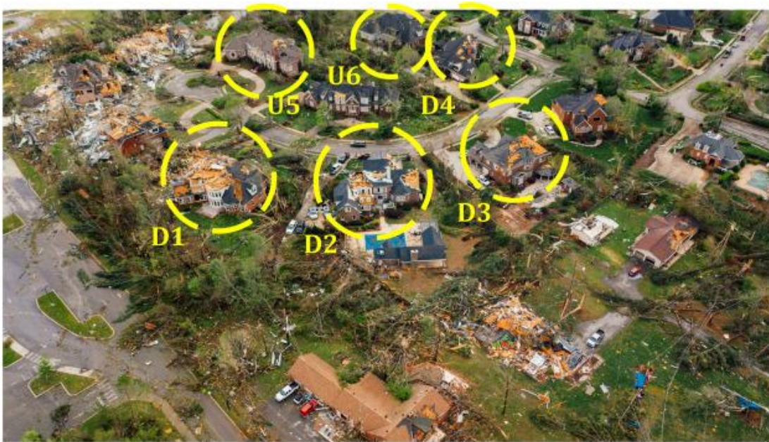
Şekil 3.55 : Yöntem kullanılarak yapılan hasar tespit uygulaması: U: Undamaged ve D: Damaged.
