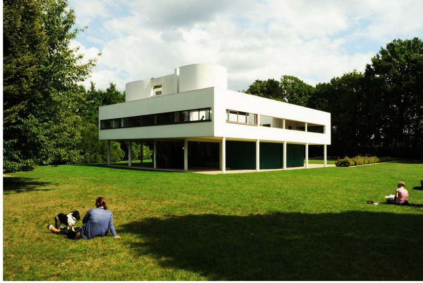
Şekil 3.3 : Mimarlık medyumunda görsel temsilleriyle karşılaşma olasılığının yüksek olduğu yapılardan Villa Savoye'un fotoğraflarından biri (Url-3).
