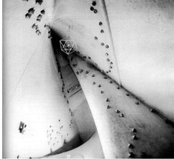
Şekil 2.4 : Pavyonun iç çeperlerine yerleştirilmiş olan hoparlörler ile mekan içinde örgütlenen sesler (Url-2).
