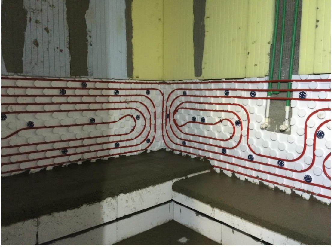
Şekil 4.25 : Hamam alt yapı imalatları.
