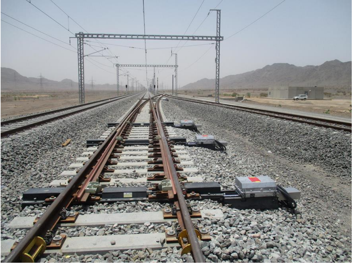
Şekil 4.9. Elektrohidrolik makas motoru
