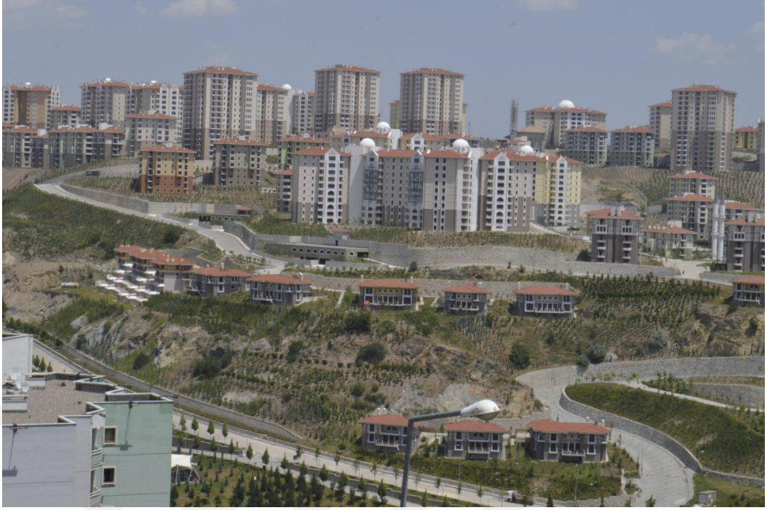
Şekil 4.5 Kuzey Ankara Girişi Projesinin Uygulandığı Hali (Orginal 2018)
