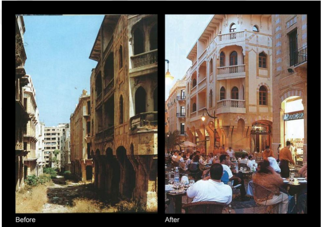
Şekil 2.9 Kentsel dönüşüm öncesi ve sonrası (www.4barchitects.com, 2017d)
