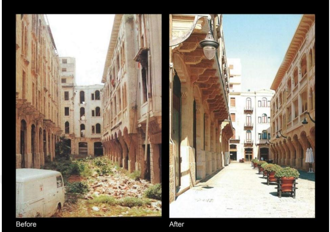
Şekil 2.10 Kentsel dönüşüm öncesi ve sonrası (www.4barchitects.com, 2017d)
