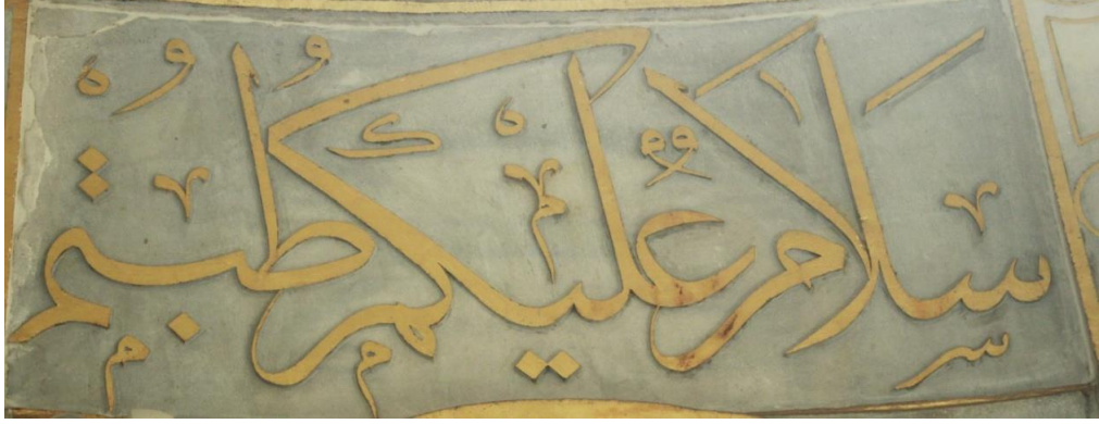
Resim 94- Şah Sultan Türbesi İç Kısım (e)
