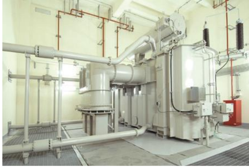
Şekil 2.28: Scoot bağlı bir trafo örneği.
