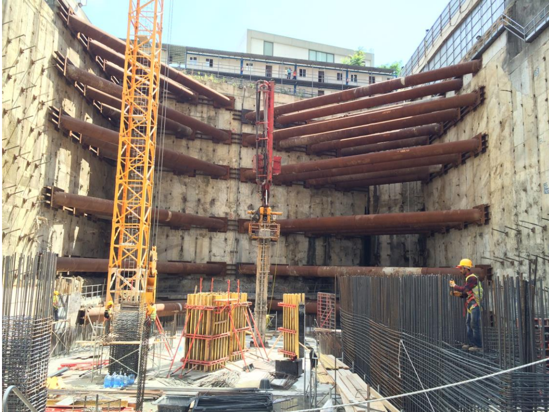
Şekil 2.1 : Çelik boru destekli iksa sistemleri.
