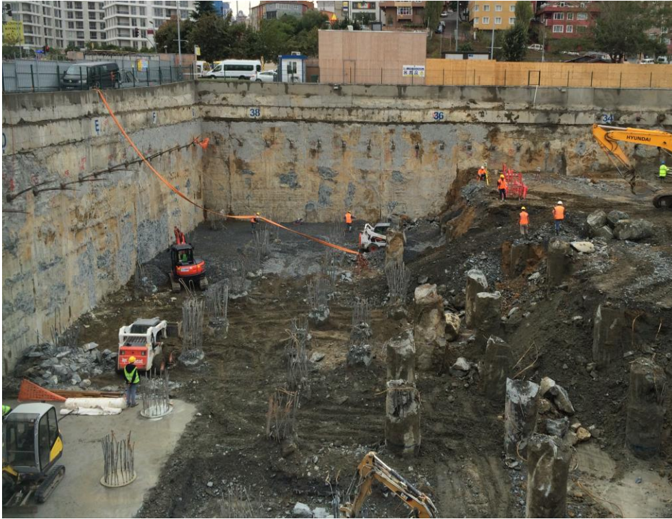
Şekil 2.5 : Diyafram duvarlı iksa sistemi.
