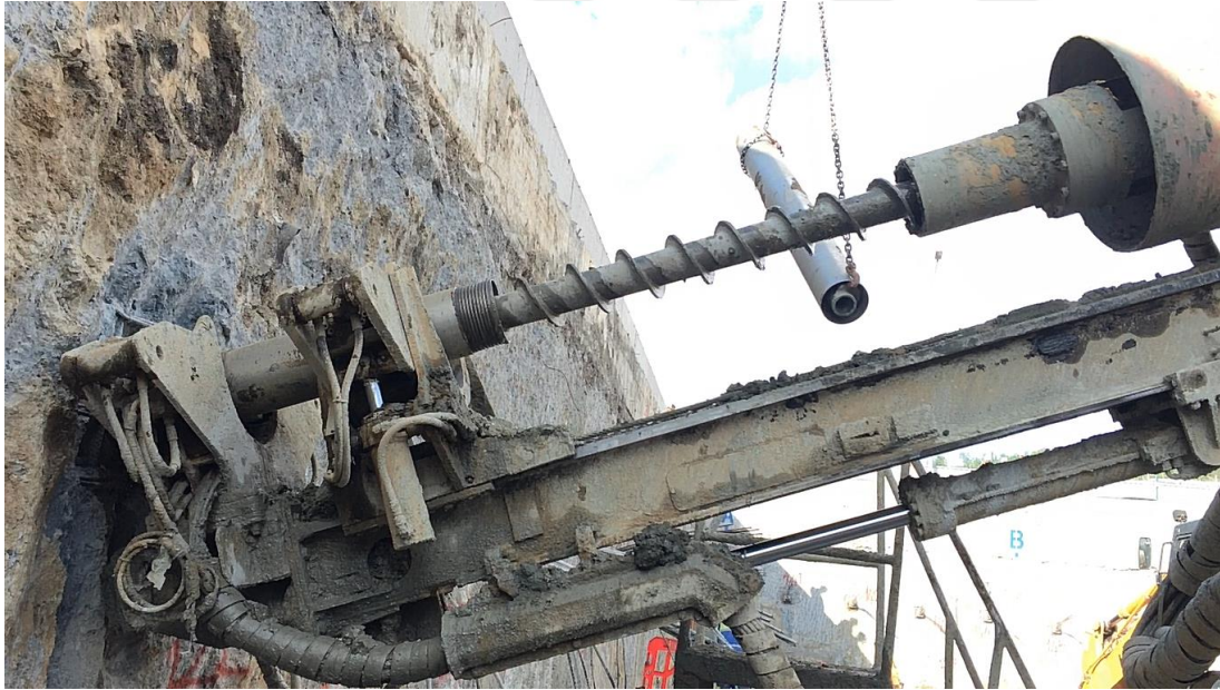
Şekil 3.5 : Muhafaza borusu yardımıyla ankraj delgisi yapılması.
