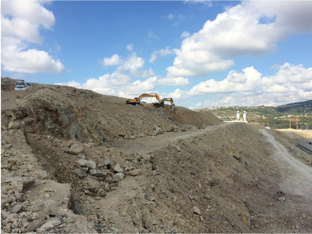
Şekil 2.8 : Şevlendirme yöntemi ile derin kazı uygulaması.
