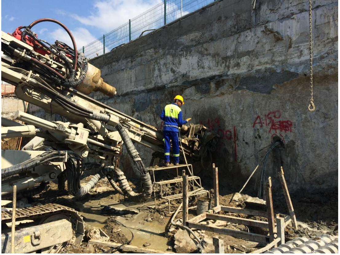
Şekil 3.4 : Ankraj delgisi yapılması.
