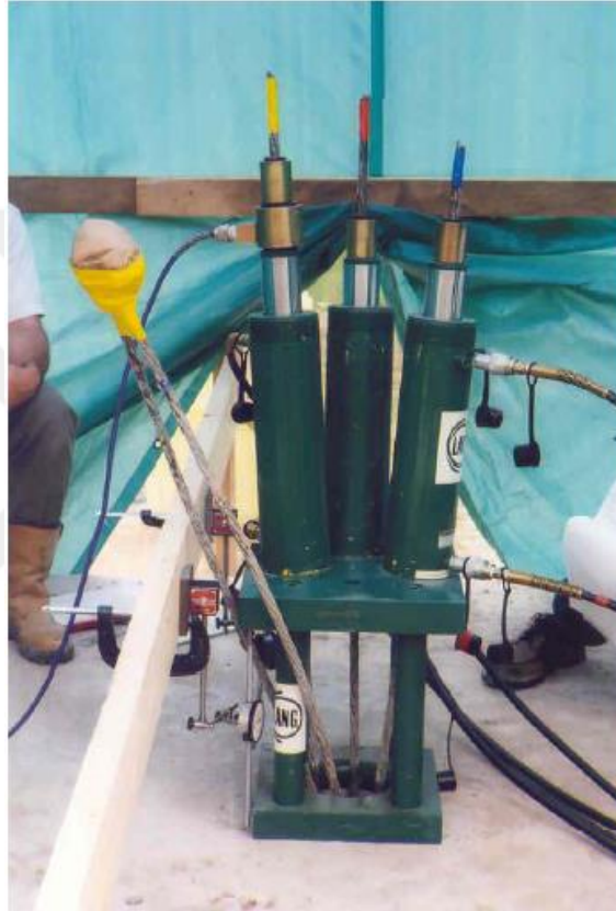
Şekil 4.3 : Ayrı hidrolik krikolar ile tek delgili çok köklü ankrajların öngerme işlemi (Bruce ve diğ, 2004).
