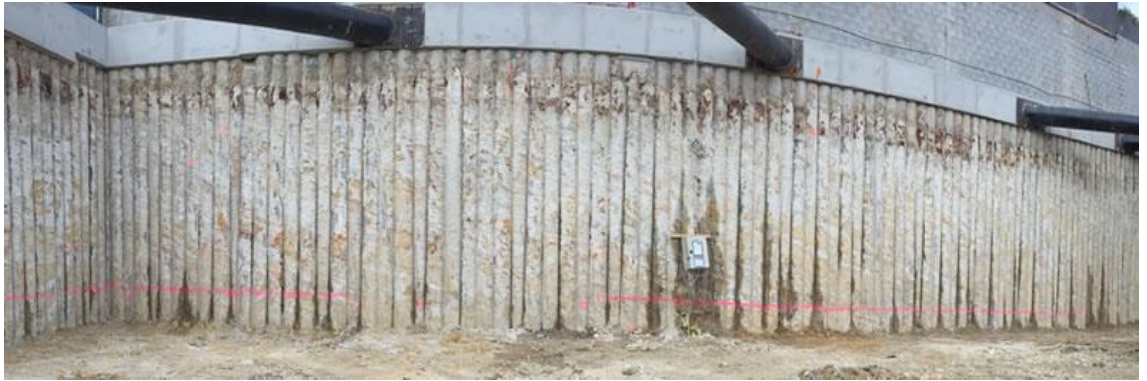
řekil 2.4 : Kesiřen kazıklı iksa sistemi.
