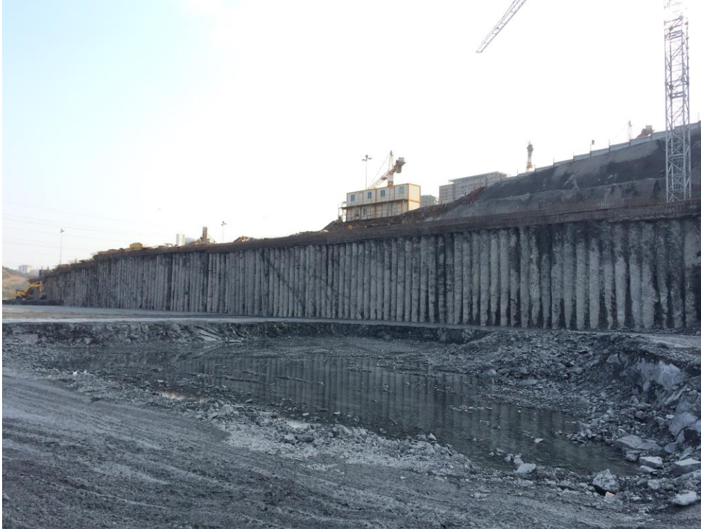
Şekil 2.3 : Konsol çalışan fore kazıklı iksa sistemi.
