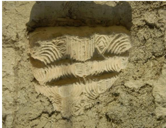
Şekil 4.100 : Devşirme olarak duvar örgüsünde kullanılmış başlık (Saner, 2009).
