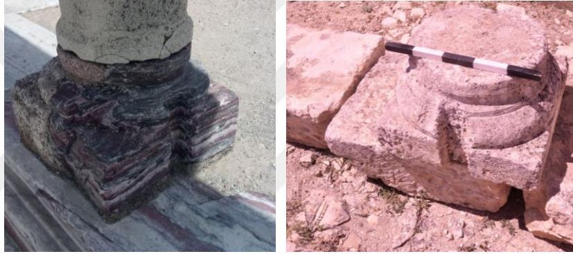
Şekil 4.8 : Selçuk Hag. Ioannes Bazilikası ve Alahan Batı Kilisesi, sütun kaidesi üzerinde levhanın oturtulduğu oyuk (Demir, 2017)
