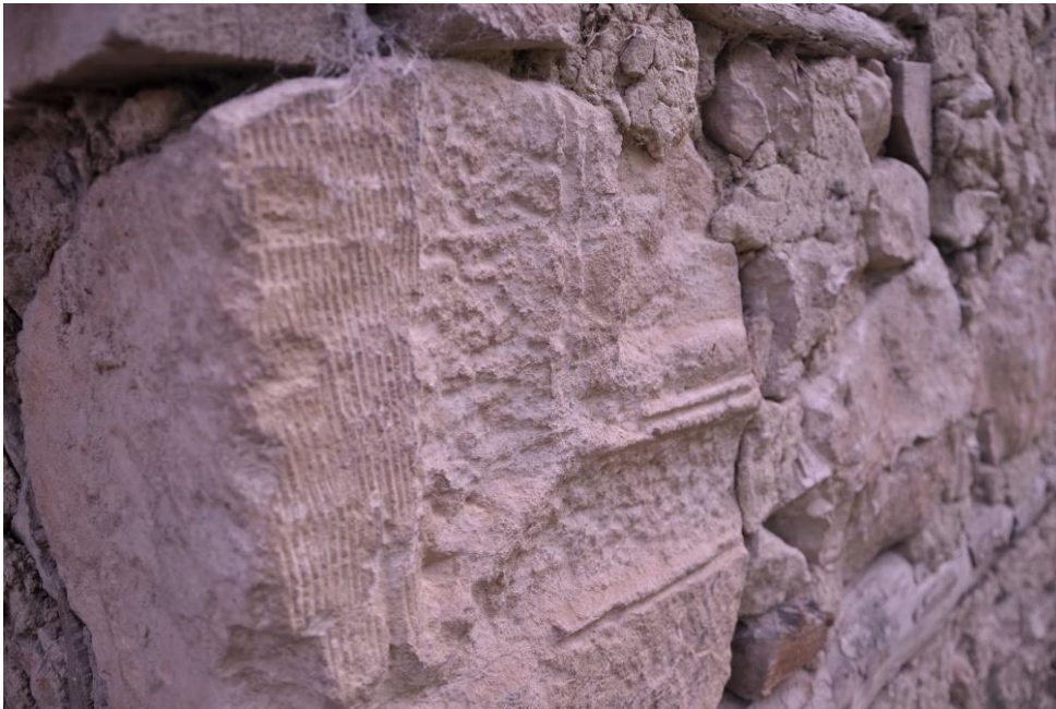
Şekil 4.4 : Murç ve tarak izleri görülebilen devşirme köşe taşı (Demir, 2017).
