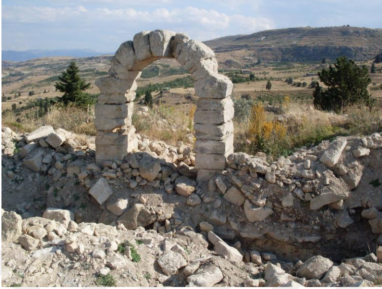
Şekil 3.1 : Kiliseden günümüze ulaşan kemerli birim (Saner, 2009).
