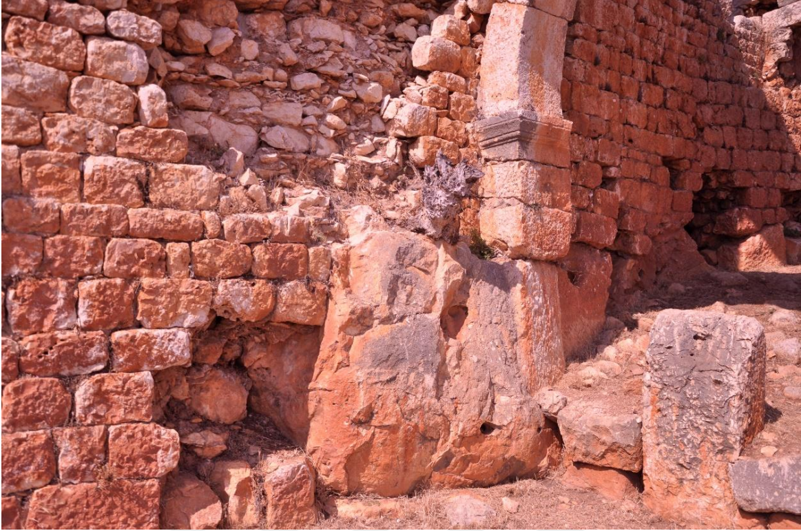
Şekil 3.12 : Kanlıdivan Kilise 4 kayanın mimariye katılması ve kesme taşların yıkıldığı kısımlarda görülen moloz taşlar (Demir, 2017).
