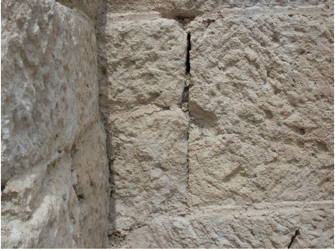
Şekil 3.11 : Kesme taş blokların arasında görülen harç (Saner, 2009).
