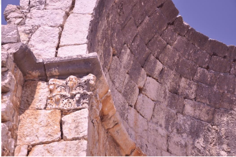
Şekil 4.69 : Kanlıdivan Kilise 1'in mekanı çevreleyen kornişleri (Demir, 2017).
