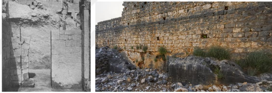
Şekil 3.15 : Alahan Batı Kilisesi kuzey odasında ve Yanıkhan Kuzey Kilisesi'nin kuzey duvarında kaya ve kesme taş kullanımı (Gough, 1963, levha 32, Url-8).
