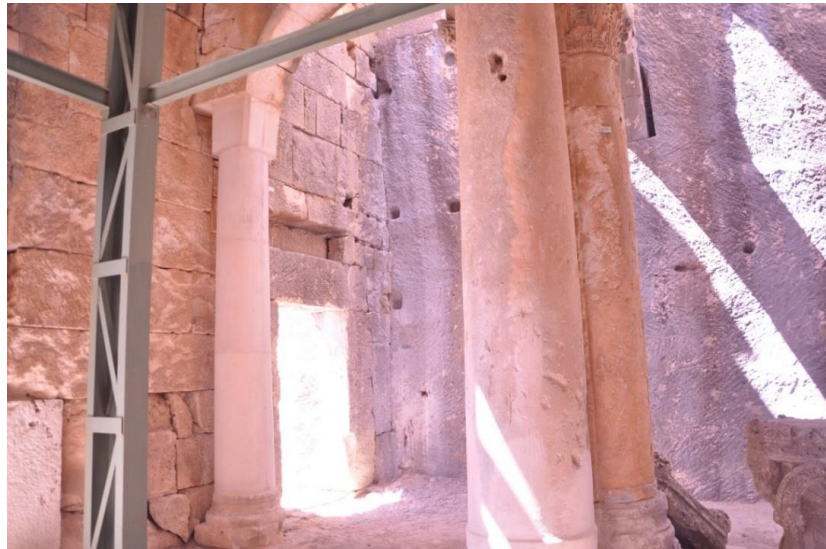
Şekil 3.16 : Alahan Doğu Kilisesi kayadan oyulmuş kuzey duvarı ve kesme taşlarla örülmüş batı duvarı kesişimi (Demir, 2017).
