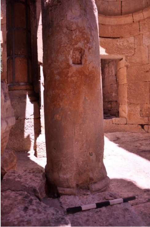
Şekil 4.15 : Alahan Doğu Kilisesi'nde yan nefleri ayıran sütunlar üzerinde yer alan korkuluk levhalarının oturduğu oyuklar, Zenonopolis payesinde her hangi bir iz görülememiştir (Demir, 2017).
