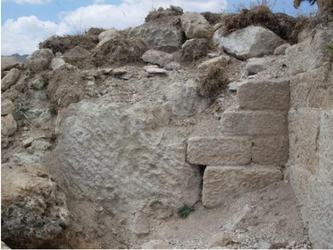
Şekil 3.9 : Batı duvarında kaya kütlesi ile kesme taş blokların birlikte kullanımı (Saner, 2009).
