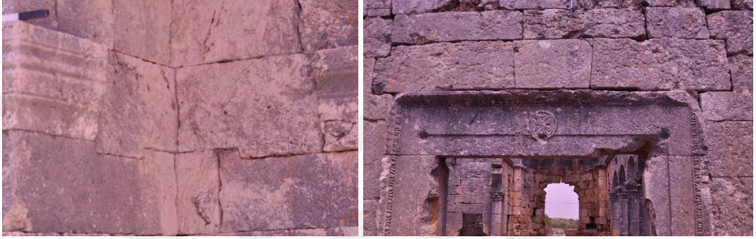
Şekil 3.23 : Korykos Transeptli Kilise'nin, Canbazlı Kilisesi'nin duvar örgüsü (Demir, 2017).
