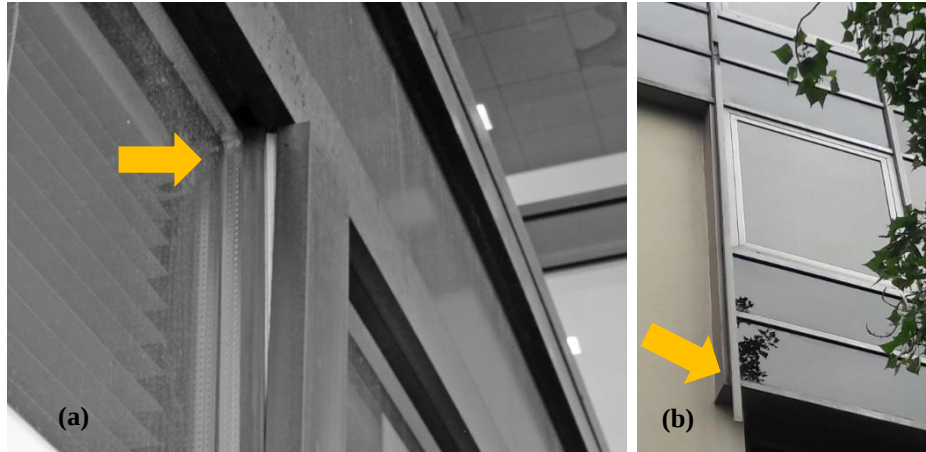
Şekil 3.10 Baskı kapaklarının sistemden ayrılması (Sanders ve Hargrove, 2012) (a), (Yalaz ve diğ. 2016) (b).
