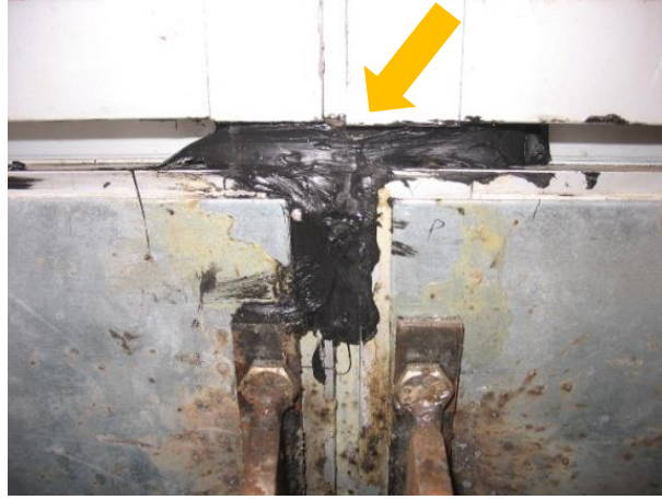
Şekil 5.15 Panel sistemde su girişi.
