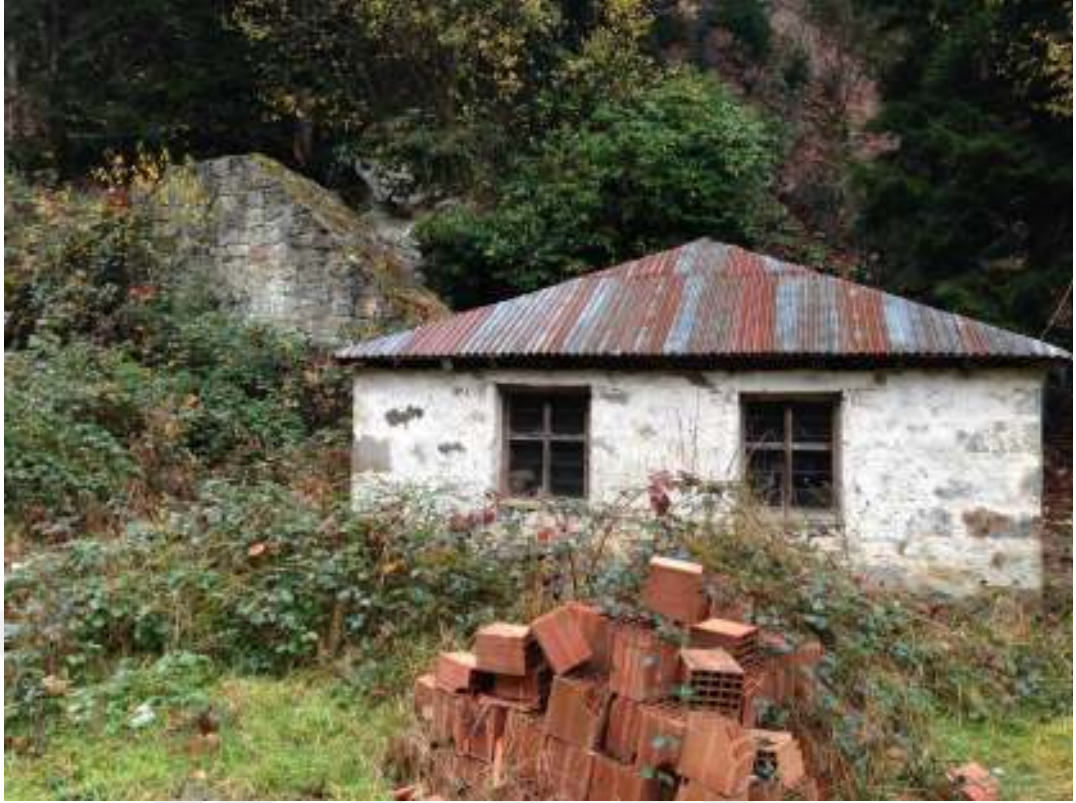
Ek A. 29: Geyikli Değirmeni doğu cephesi.
