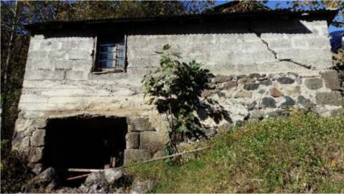
Ek A. 3: Şahmelik Değirmeni güney cephesi.
