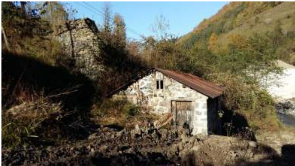
Şekil 4.6 : Üzümlü Değirmeni güneybatı cephesi.
