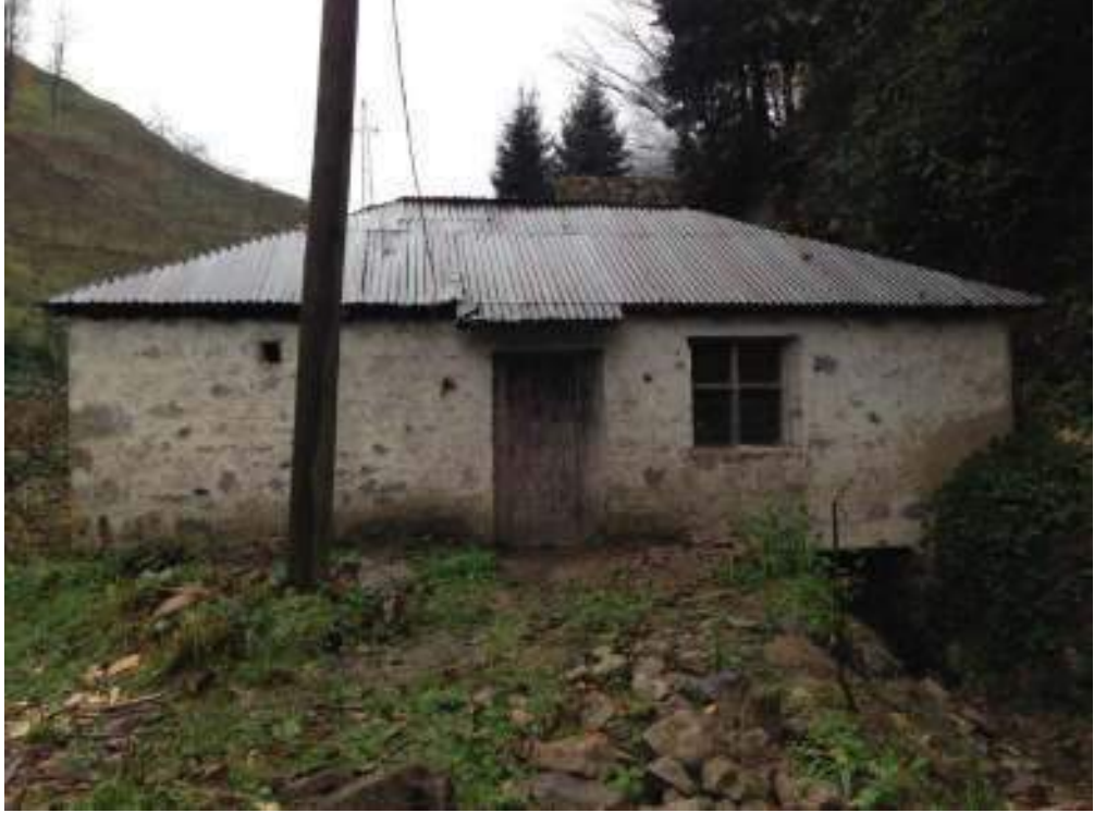
Şekil 4.18 : Geyikli Değirmeni kuzey cephesi
