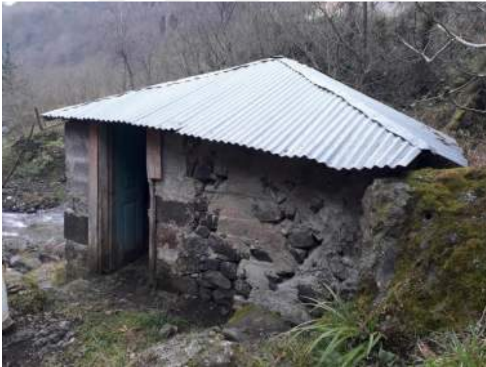
Şekil 4.2 : Şahmelik Değirmeni doğu cephesi.
