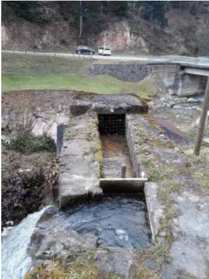
Ek A. 36: Sayvançatak Değirmeni su arkı ayırımı ve olukla birleştiği yer.
