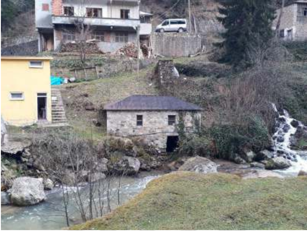
Ek A. 35: Sayvançatak Değirmeni batı cephesi.
