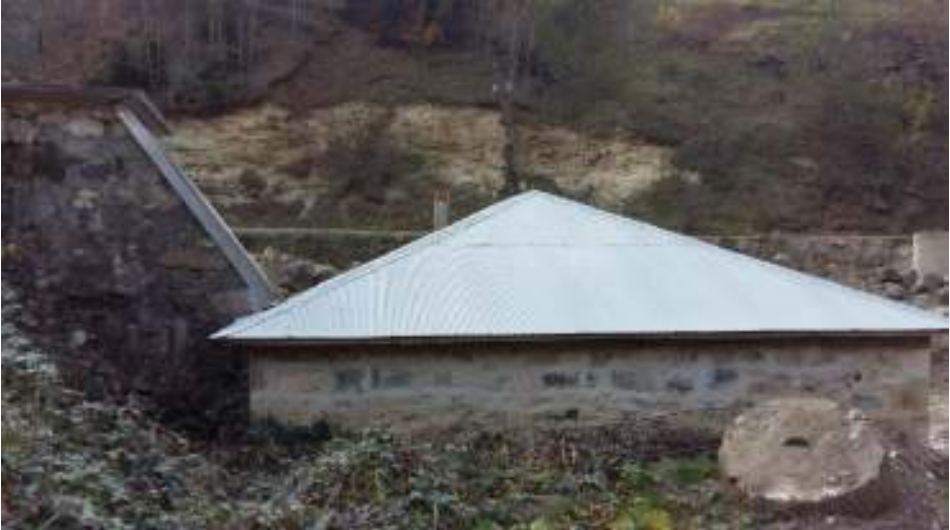
Ek A. 19: Dorukkiriş Değirmeni doğu cephesi ve su bendi.
