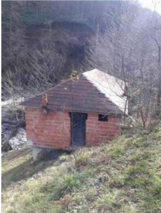
Ek A. 11: Dereköy-Tepeağız Ortak Değirmeni kuzey cephesi.
