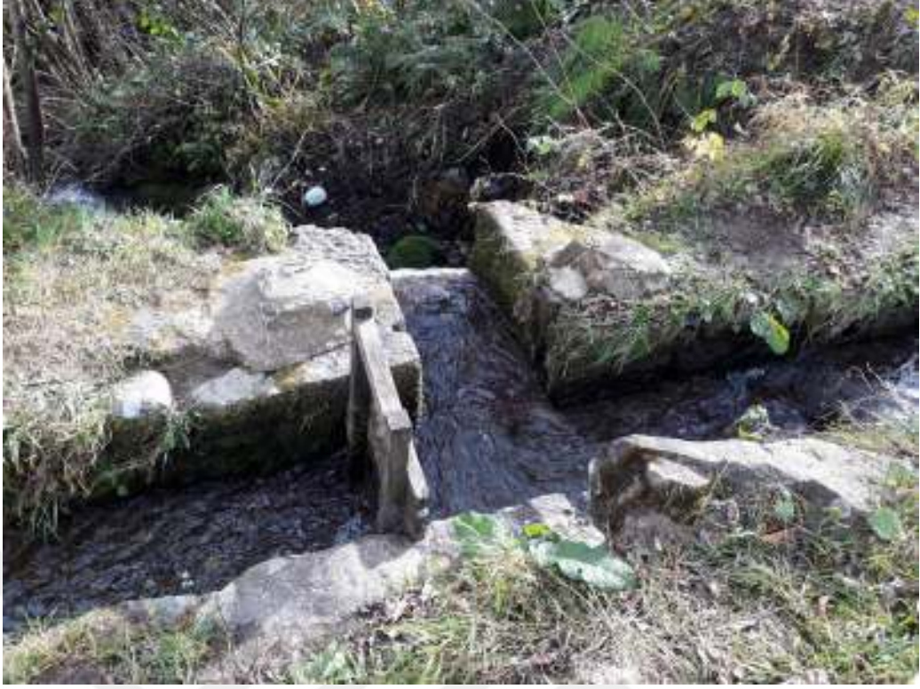
Ek A. 12: Dereköy-Tepeağız Ortak Değırmeni tali ark ayırımı ve ahşap kapak.
