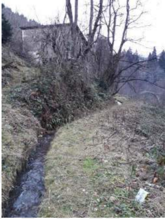
Ek A. 37: Sayvaçatak Deęirmeni doęal su arkı ve taş köprü.
