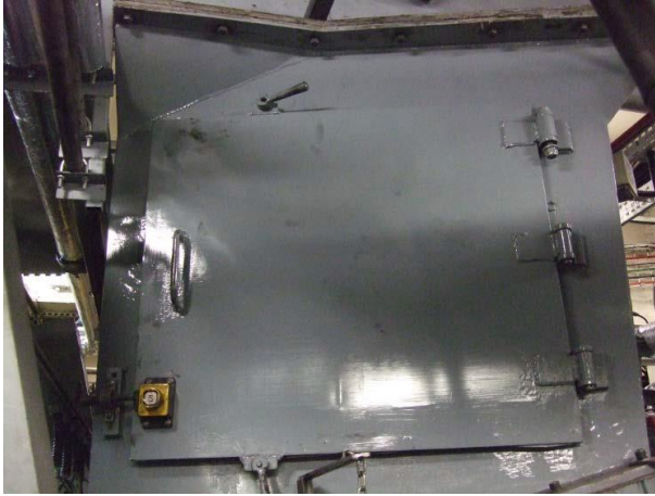
Resim 3.4. Bunker kapağı ve castell anahtar detayı
