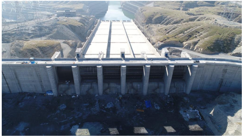
Şekil 3.2. Ilisu Barajı dolusavak eşik yapısı ve Beton Barajdan bir görüntü
