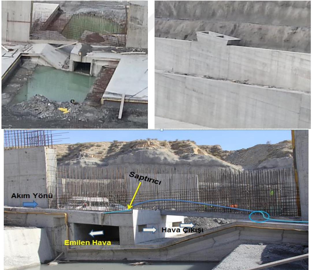
Şekil 3.7. Dolusavak şüt kanalı havalandırıcısı inşaatından görüntüler
