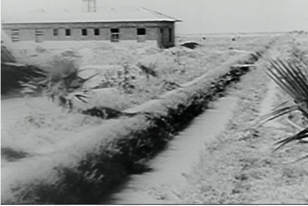
Resim 4.28. Ara kollar ile daha geniş bir coğrafya sulama imkanına kavuşur
