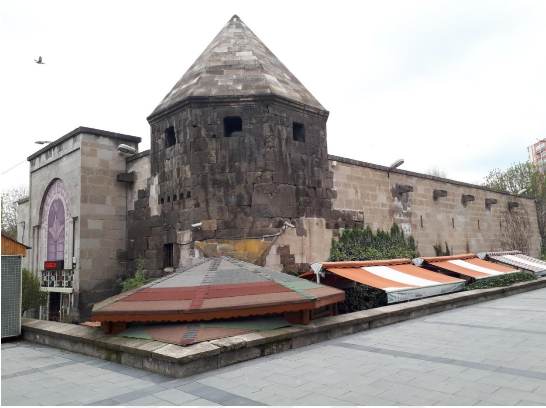
Resim 33: Kayseri Avgunu Medresesi Genel Görünüm (Ata KAYA 2016)
