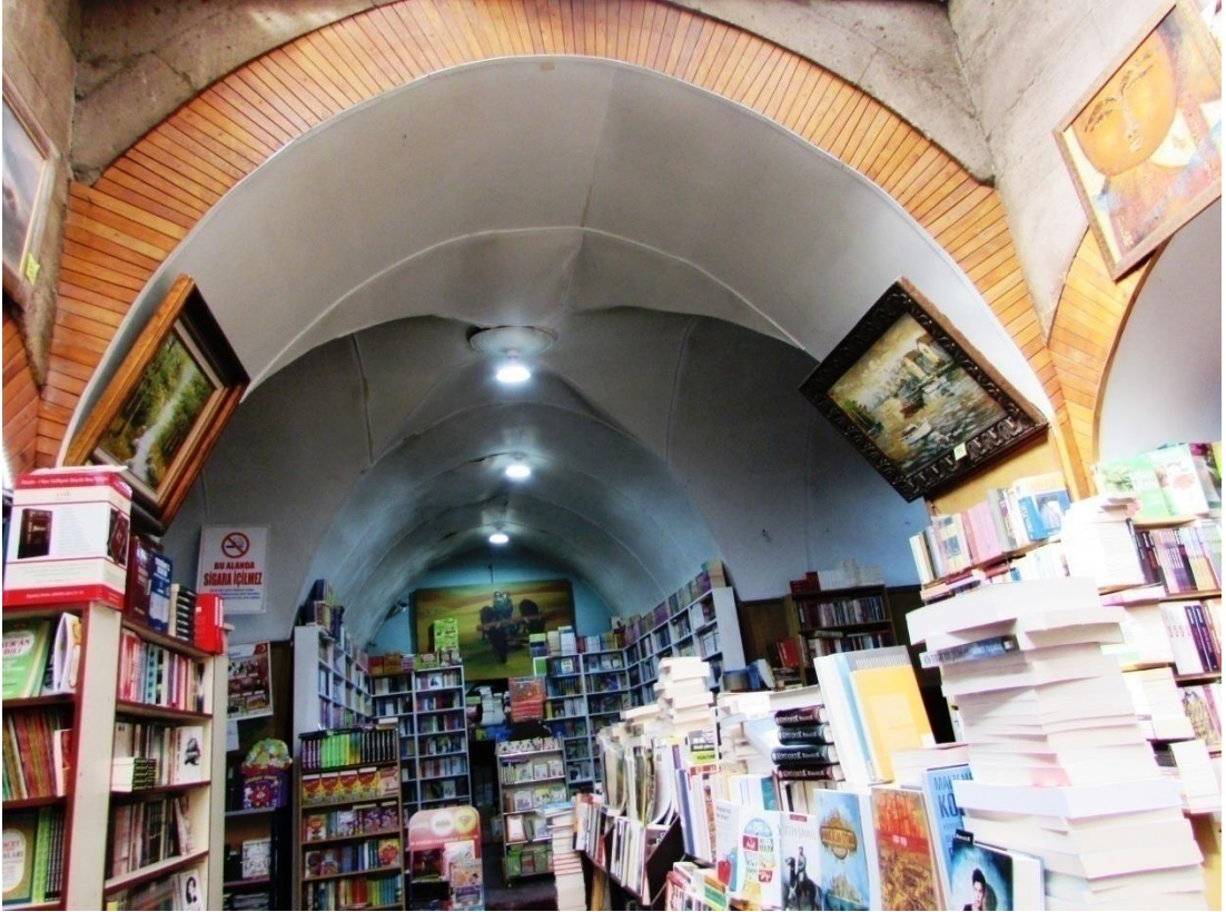
Resim 26: Medrese Ana Eyvanına Geçişi Sağlayan Çapraz Tonoz (Ata KAYA 2016)
