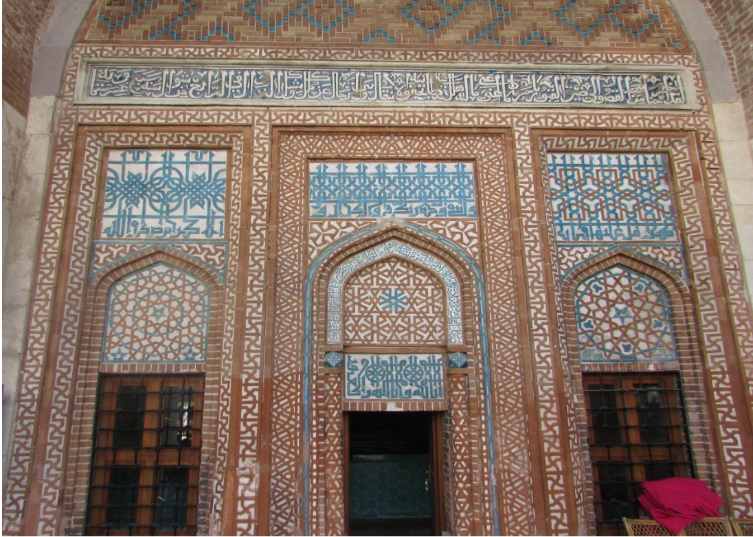
Resim 10: Keykavus Şifahane Türbe Cephesi (Ata KAYA 2016)
