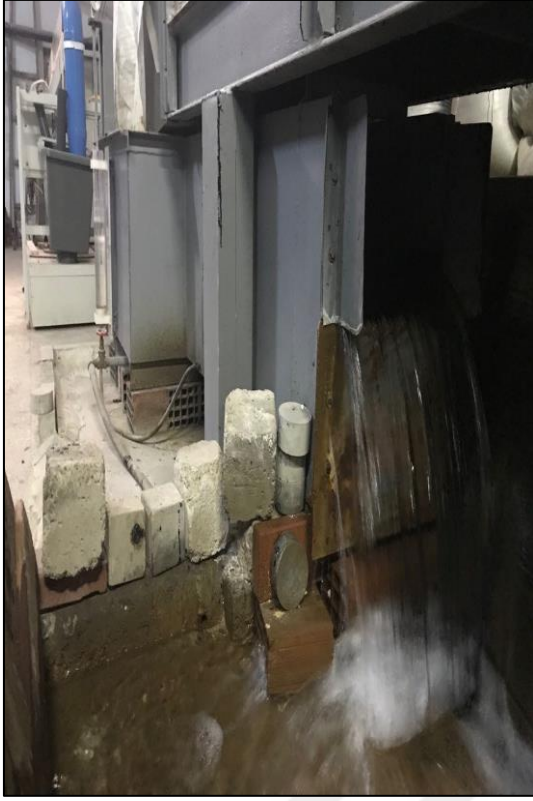
Resim 4.1. Debi ölçümünün gerçekleştirildiği savak
