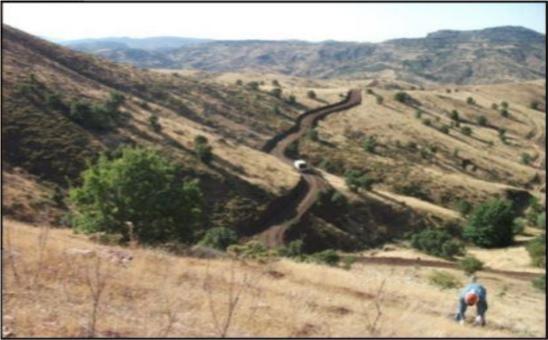
Şekil 5.14 Dozer Çalışması Yapılarak Açılan Yol [11]
