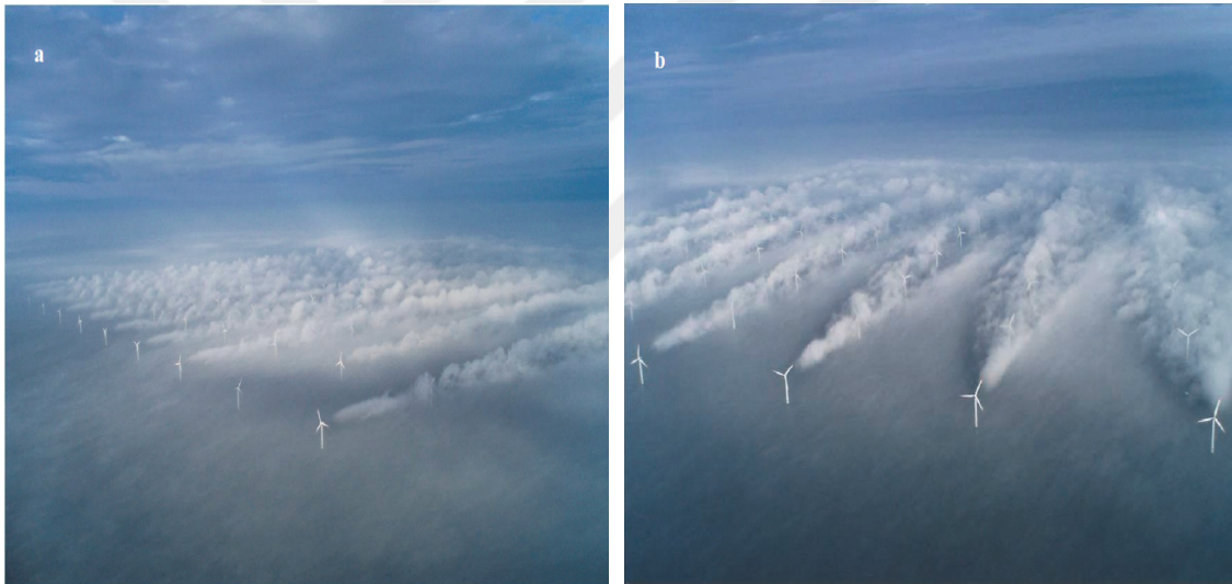
Şekil 4.7. (a) Horns Rev 1 deniz üstü rüzgâr çiftliği (12 Şubat 2008 tarihinde güneydoğudan yaklaşık 10:10 UTC'de fotoğraflandı.) (b) (a) ile aynıdır, ancak kısa bir süre sonra güneyden görülmektedir. Fotoğrafçı: Christian Steiness. (Hasager vd, 2013).
