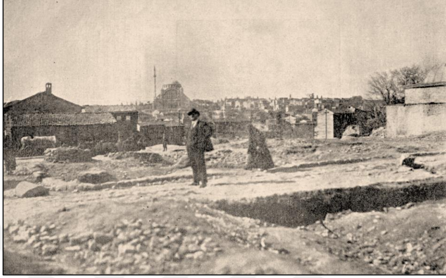
Şekil 3. 12 Semiz Ali Paşa Medresesi’nden Edirnekapı’ya yol çalışması [68]
