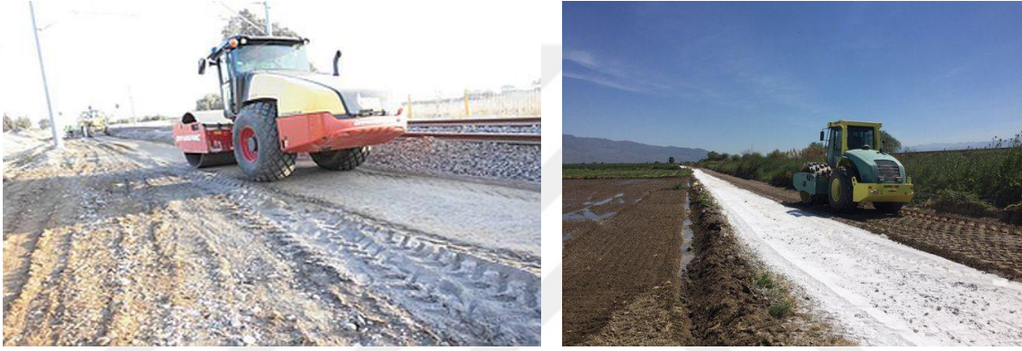
Fotoğraf 3.1. Kireçle stabilizasyon (URL-2, 2018)
