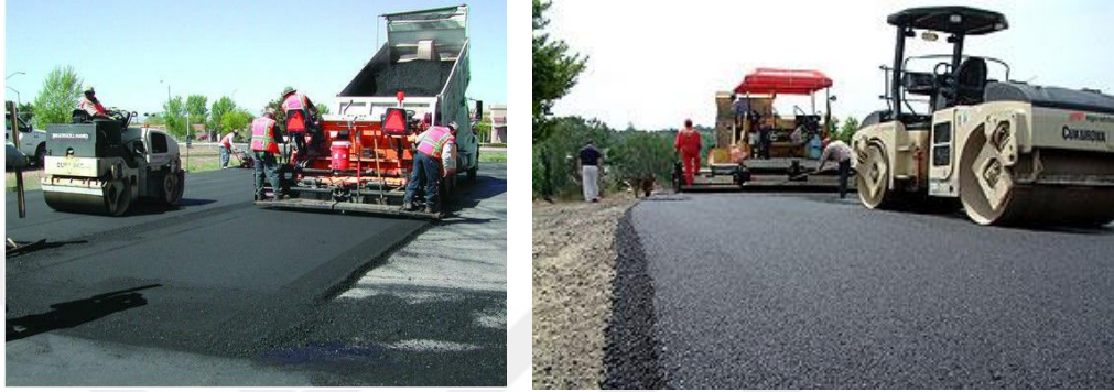
Fotoğraf 3.2. Bitüm ile stabilizasyon (URL-1, 2018)
