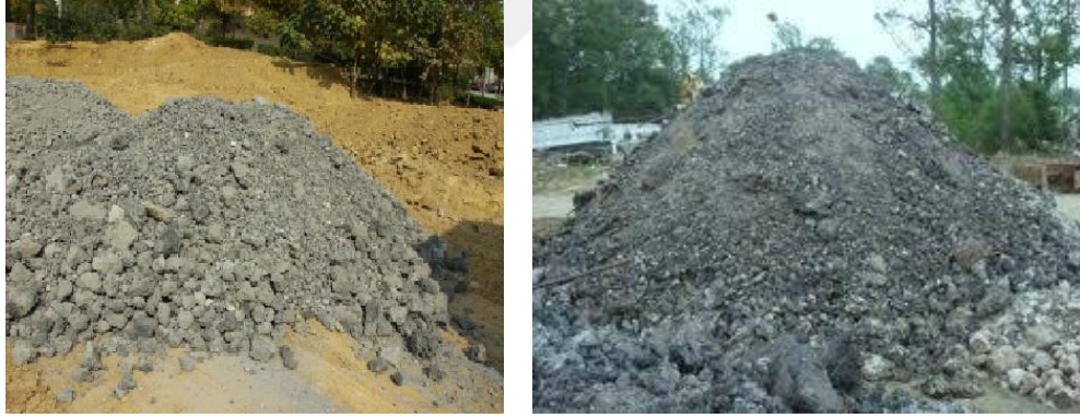
Fotoğraf 3.3. Metal cürufu ile stabilizasyon (URL-3, 2018)
