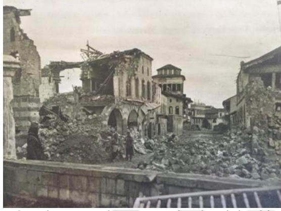
Şekil 6.6. Antep Harbi'nde Fransız kuşatması altında yıkılan binalar (Gaziantep Şehir Kimliği Çalıştay, 2015)
