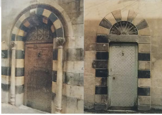
Şekil 6.16. Antep Evi giriş kapısında karataş (bazalt) kullanımı (Başgelen, 1999, sf:75)
