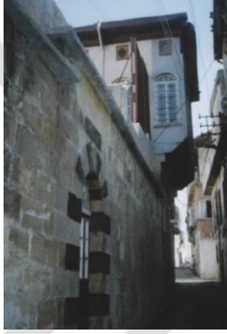
Şekil 6.14. 09 Tescil Nolu Ev sokaktan görünümü (Tatlıgil, 2005, 42-45)
