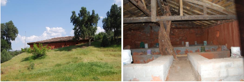
Görsel 109, 110: Türbenin dışarıdan ve içeriden görünüşü
