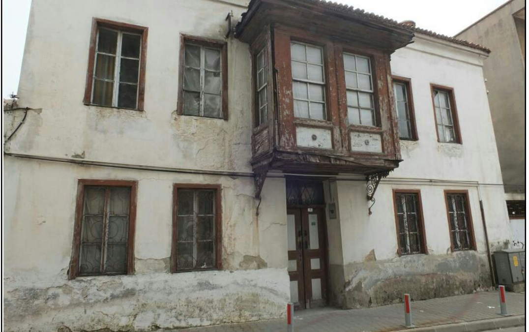
Fotoğraf 45. Muğla Belediyesi K lt r Evinin Restorasyondan  nceki Durumu
