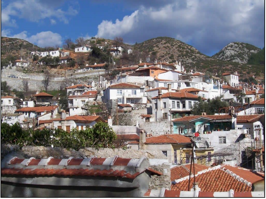
Fotoğraf 35. Hacı Rüstem Mahallesinde Eğimden Kaynaklanan Kot Farkı
