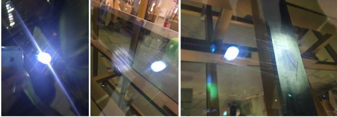
Şekil 4.6 : Low-E kaplamalı camlarda ısı yalıtım ünitesi üretimi esnasında oluşan çizik hasarları.
