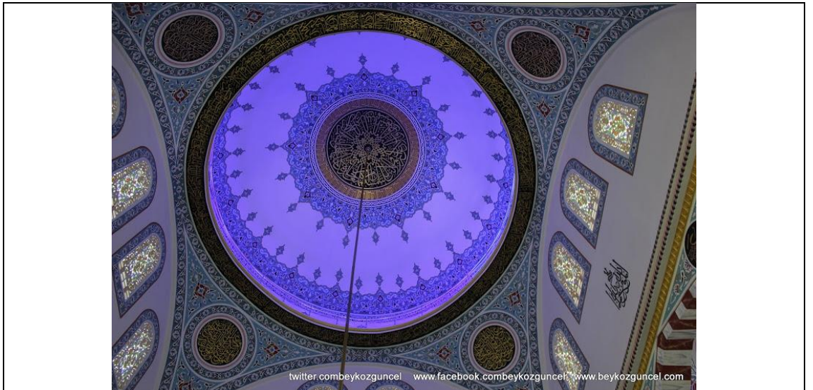
Şekil 5.64: Karlıtepe Merkez Camii Kubbe Gizli Aydınlatması
