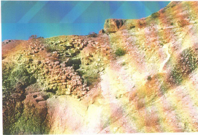
134. Darende Kalesi Batı Cephesindeki Sur Kalıntıları
