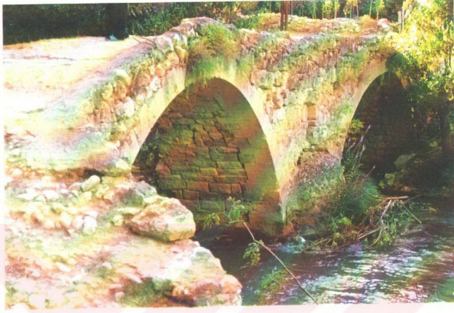
109. Abidin Paşa Köprüsü Genel Görünüş
