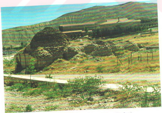
80. Hüseyin Paşa Hamamı Kuzey Cephesi
