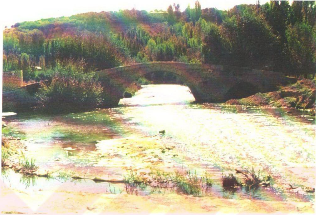
111. Uzunok Köprüsü Güneyden Görünüş
