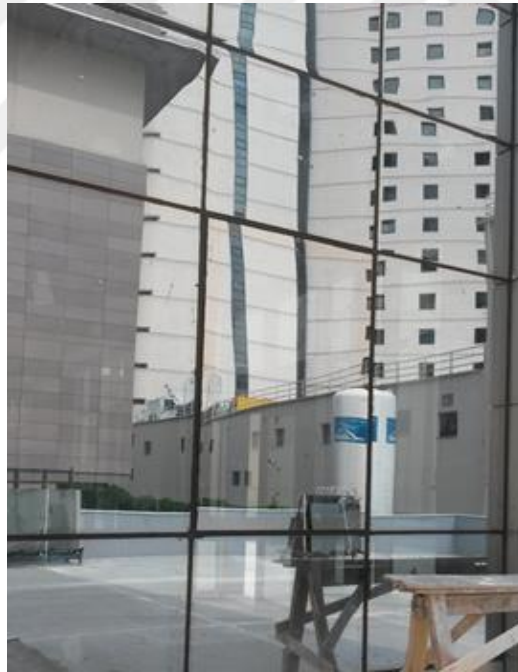
Şekil 1.2. Silikonlu alüminyum giydirme cephe sistemi.
