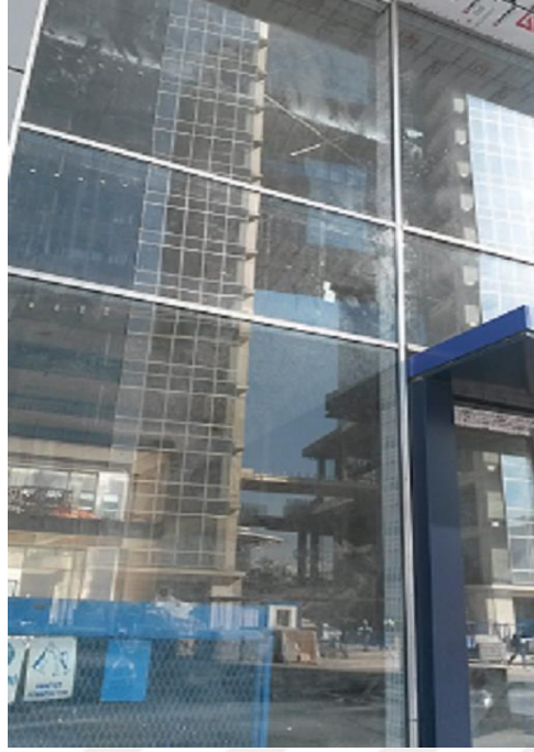
Şekil 1.1. Kapaklı alüminyum giydirme cephe sistemi.
