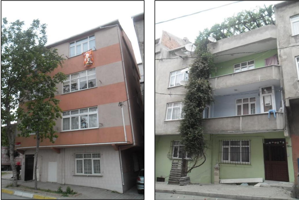
Şekil 4. 30 Kemalpaşa kentsel dönüşüm alanı mevcut yapı fotoları
