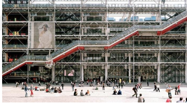
Resim 69 Merdivenler, Asans rler ve Ta ıyıcı Siteminde Bulunduęu Cephe (URL-95)
