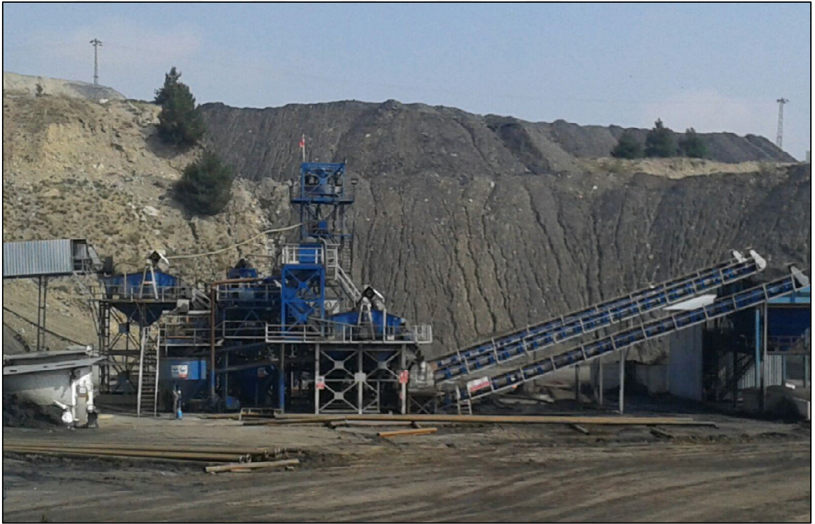
Şekil 3.1. Lavvar tesisinden genel bir görünüm
