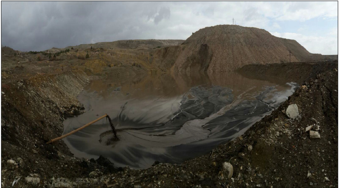
Şekil 4.3. Tunçbilek lavvar tesisine ait şlam havuzu
