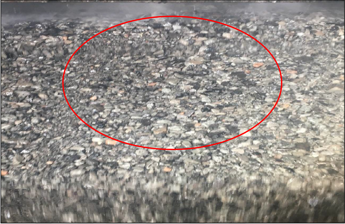
Şekil 3.2. 5-18 mm boyutlarda kaçak malzeme
