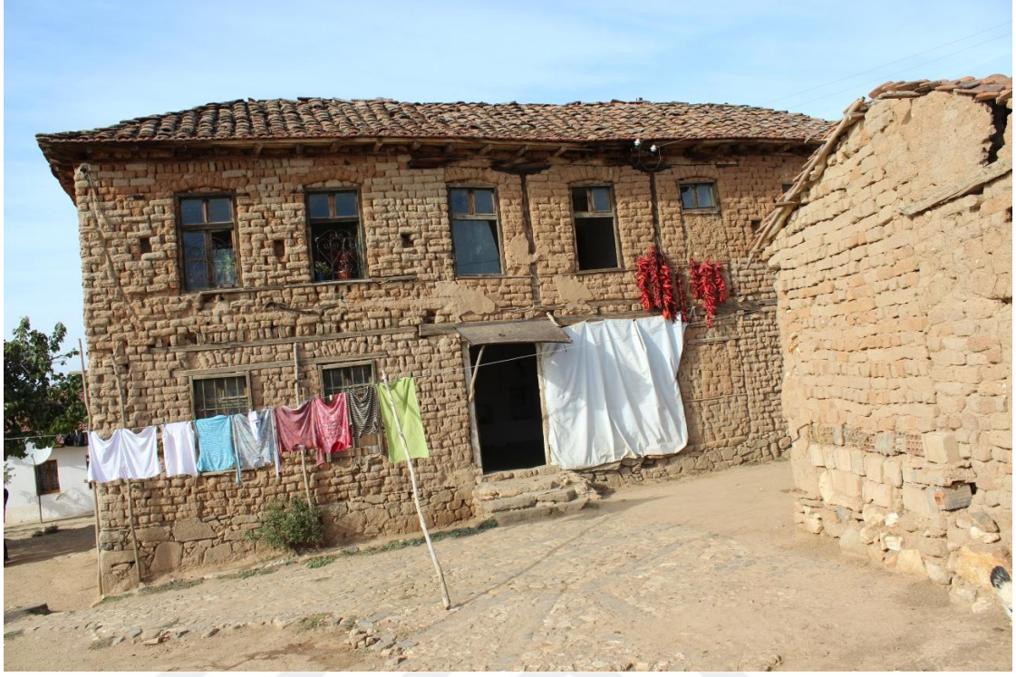
Fotoğraf 7: Kanatlar Köyünde Kerpiç ve Tuğladan yapılmış Geleneksel Bir Ev.
