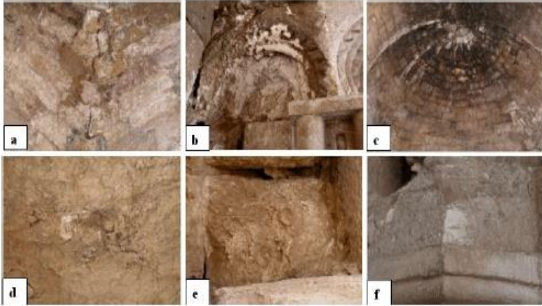
Kalenin İç Kısımlarında Bozulma Yönleri Gösteriliyor (Kaynak : Mohamed El-Gohary,2008).
