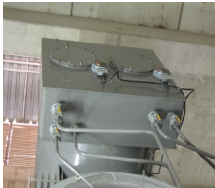
Şekil 7.14: Kademe ile domların ortak genleşme deposu
