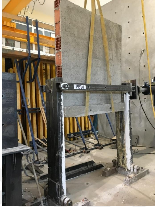
Şekil 3.6. Hazırlanan dolgu duvarların deney düzeneğine yerleştirilmesi
