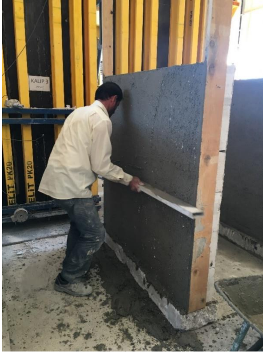
Şekil 3.4. Dolgu duvarların örülmesi ve sıvanması
