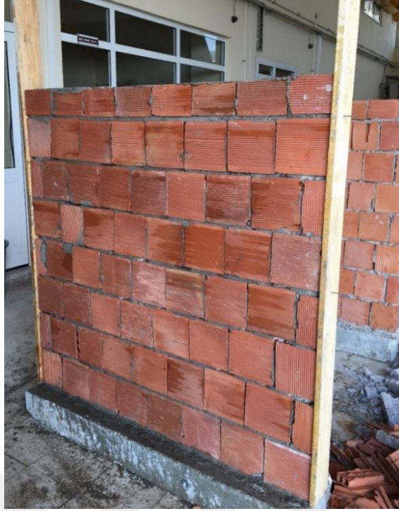
Şekil 3.1. Yatay delikli tuğla bloklar kullanılarak üretilen dolgu duvar
