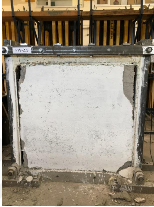
Şekil 4.38. PW-2.5 dolgu duvarının deneyler sırasında görüntüsü
