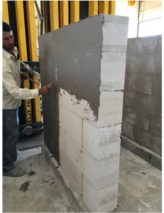
Şekil 3.4. Dolgu duvarların örülmesi ve sıvanması
