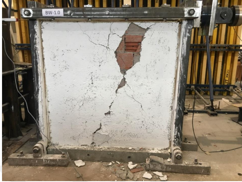
Şekil 4.7. BW-1.0 dolgu duvarının deneyler sırasında görüntüsü
