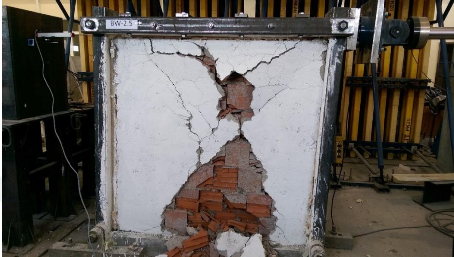
Şekil 4.18. BW-2.5 dolgu duvarının deneyler sırasında görüntüsü
